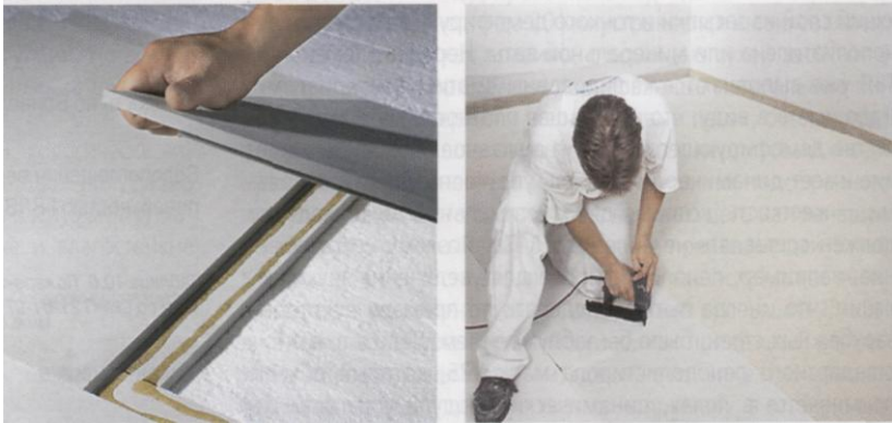
Рис. 1.38. Кріплення елементів підлоги
