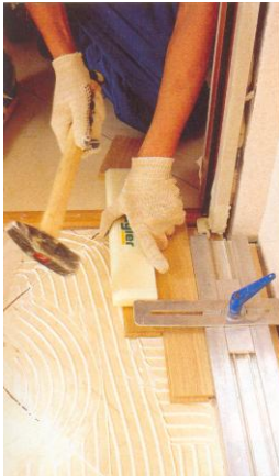
Рис.2.15. Початковий етап укладання штучного паркету з циркулярною пил-використанням накладного профілю
