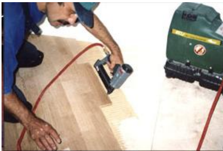
Рис.2.19. Фіксація паркетних планок спеціальними цвяхами з обтисковою голівкою, із застосуванням пневматичного пістолета
