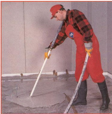
Рис. 1.13. Приготовлена маса виливається змішувально-нагнітальними агрегатами, безупинно й рівномірно розподіляється по поверхні до проектних позначок, відзначених реперами.
