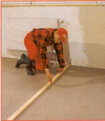
Рис. 1.8. По поверхні виливки можна ходити після закінчення приблизно 10 годин, залежно від існуючих умов у приміщенні. Після цього часу виконуються розширювальні (деформаційні) шви, попередньо позначені на стіні.
