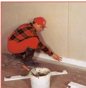
Рис. 1.10. Насамперед, необхідно укласти ізолюючий шар у стіни. При цьому використовуються відокремлюючі теплоізоляційні смуги з пінополістиролу (товщиною мін. 0,5 см).
