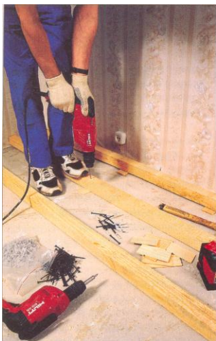
Рис.2.9. Установка й кріплення лаг
