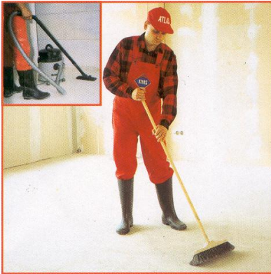
Рис. 1.1. Основа під TERPLAN N повинна бути міцною, щільною, чистою. Забруднення всякого роду, жирні плями від масел, ветхі й нещільно прилеглі шари віддаляються механічно, а поверхня пилесоситься.
