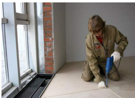
Рис. 1.17. Кріплення шару вологостійкої фанери
