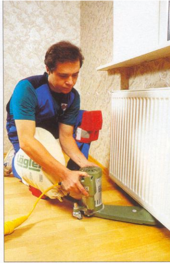
Рис.2.21. Грубе й середнє шліфування машиною для кутів і сходів
