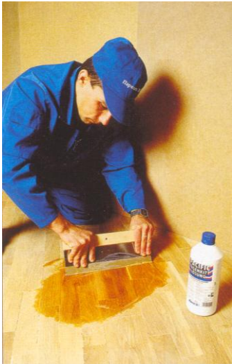
Рис.2.22. Шпаклівка паркету складами на основі деревного пилу
