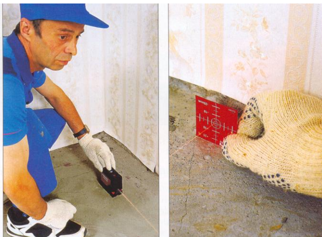
Рис. 2.6. Вимірювання площинності і ухилу основи лазерним нівеліром
