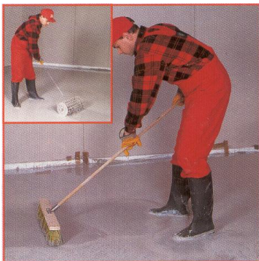
Рис. 1.14. Після закінчення виливання маса попередньо вирівнюється струшуючими рухами широкою щіткою з твердими довгими ворсинками, а також валиком або алюмінієвою рейкою.
