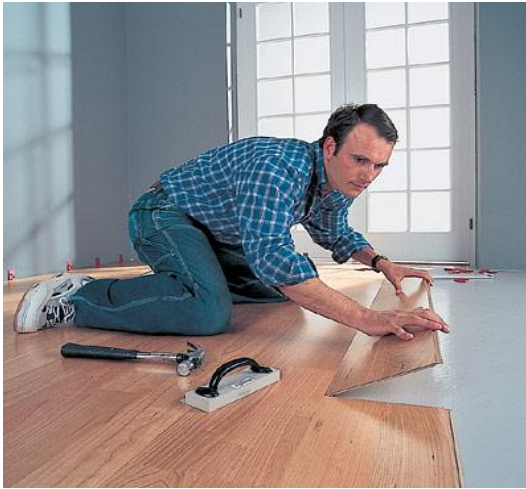
Рис. 2.33. Стикування панелей методом повороту
