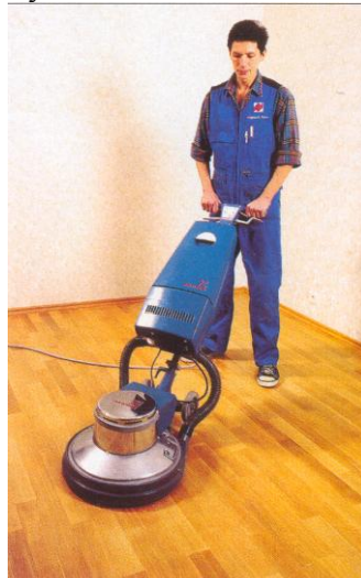
Рис.2.23. Тонке шліфування паркету машиною
