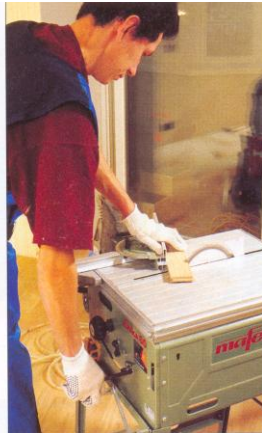
Рис.2.15. Початковий етап укладання штучного паркету з циркулярною пил-використанням накладного профілю
