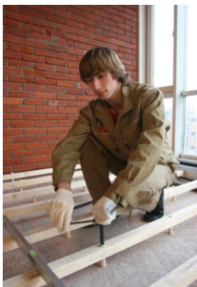
Рис. 1.16. Вирівнювання лагів за рівнем
