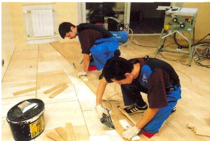
Рис.2.18. Процес укладання паркету на об'єкті
