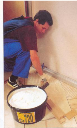
Рис.2.17. Укладання паркету на паркетний клей, який наноситься зубчастим шпателем
