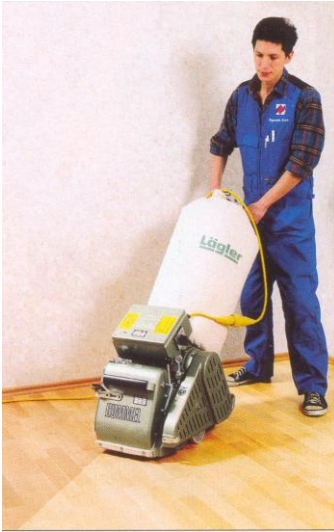
Рис.2.20. Грубе й середнє шліфування паркету спеціалізованими машинами
