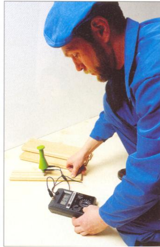
Рис.2.14. Контроль вологості паркетних планок перед укладанням
