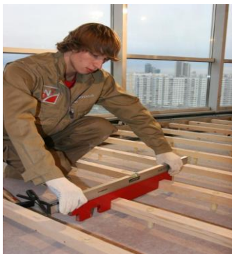
Рис.1.15. Установка лагів
