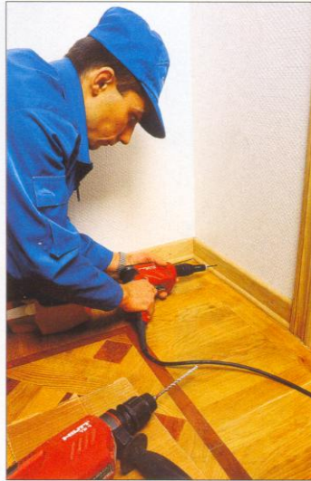
Рис.2.25. Розкрій і кріплення плінтусів до стіни на шурупи
