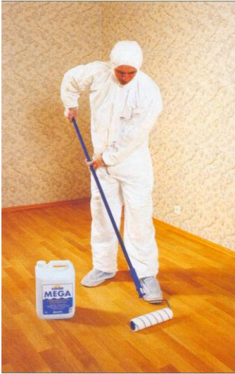
Рис.2.24. Нанесення ґрунтувального шару лаку. Нанесення 2-3 шарів основного лаку.
