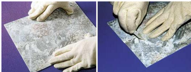
Рис.2.19.Стыковка полотнищ линолеума и заклеивание стыка скотчем
