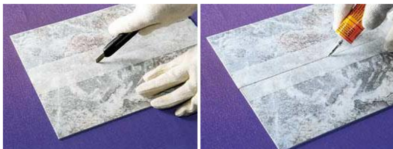
Рис.2.20. Разрезание скотча над стыком и нанесение в него клея
