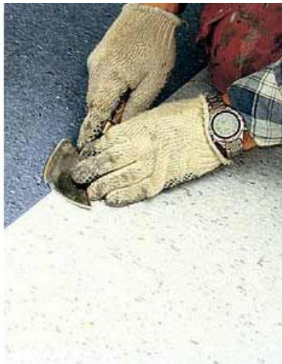
Рис.2.18. Срезание излишков шнура и шлифовка шва
