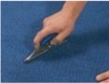
Рис.2.5. По обозначенной линии делают разрез ножом: толщина его лезвия соответствует расстоянию между рядами ворса
