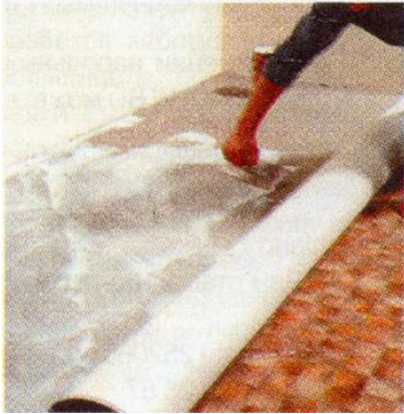
Рис.2.10.Нанесение слоя клеящего состава
