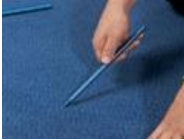
Рис.2.4. С помощью специального инструмента (разделитель ворса) определяют линию разреза, так, чтобы не повредить ворс
