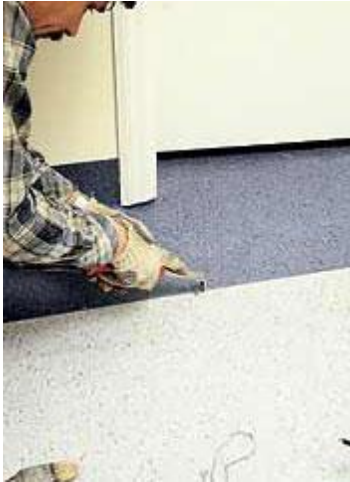
Рис.2.16. Выполнение паза между полотнищами линолеума
