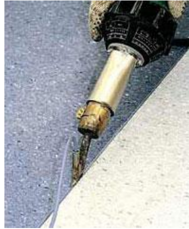
Рис.2.17. Сварка линолеума при помощи шнура
