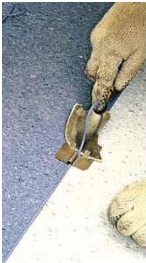
Рис.2.16. Выполнение паза между полотнищами линолеума
