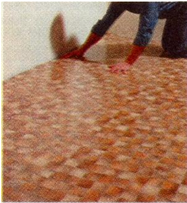
Рис.2.11.Укладка и разглаживание линолеума
