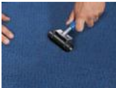
Рис.2.8. Шов на месте стыка выравнивают специальным валиком так, что шов становится совершенно незаметным
