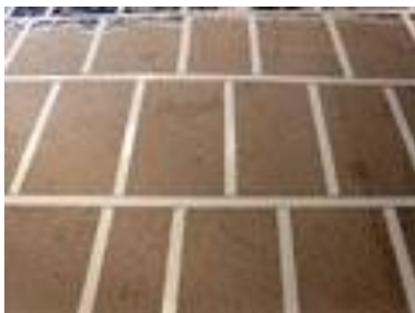
Рис.2.2. В данном примере скотч уложен "сеткой". Подобный способ применяют, как правило, в помещениях большой площади
