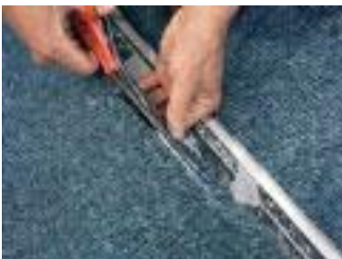
Рис.2.3. Ковровое покрытие можно разрезать и подрезать только специальными ножницами или ножом
