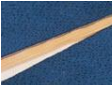
Рис.2.6. Под края двух кусков, которые нужно состыковать, подкладывают термоленту: выравнивают один край и придвигают другой
