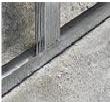
Рис. 2.12. Соединение винтами-саморезами направляющих профилей со стойками на потолке и полу
