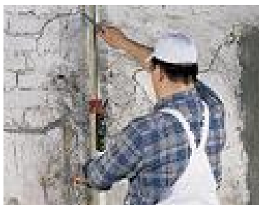
Рис. 2.4. Нанесение линий расположения вертикальных профилей
