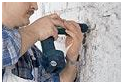
Рис. 2.5. Просверливание отверстий под дюбели
