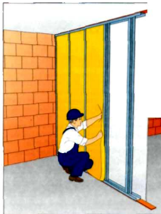
Рис. 2.20. Монтаж тепло-изоляционного материала
