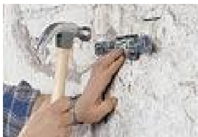
Рис. 2.6. Крепление прямых подвесов
