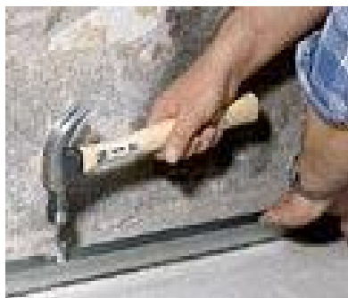
Рис. 2.9. Крепление направляющих профилей
