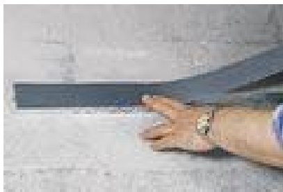
Рис. 2.10. Наклеивание резиновых уплотнителей
