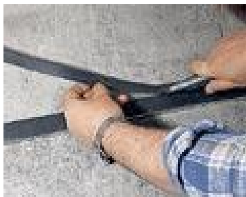
Рис. 2.11. Удаление излишков резинового уплотнителя
