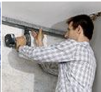
Рис. 2.8. Сверление отверстий под дюбели в потолке
