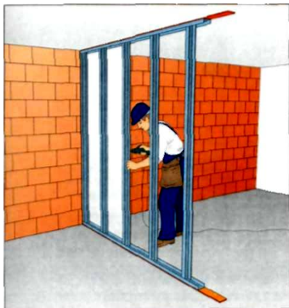
Рис. 2.19. Монтаж листов гип-сокартона с одной стороны
