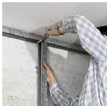
Рис. 2.12. Соединение винтами-саморезами направляющих профилей со стойками на потолке и полу
