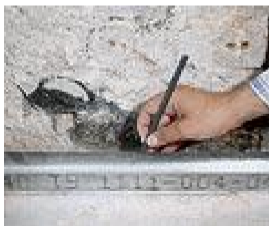
Рис. 2.2. Нанесение на пол линий расположения направляющих профилей
