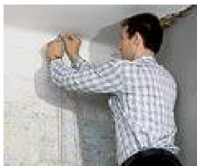
Рис. 2.3. Перенос линий разметки на потолок при помощи отвеса
