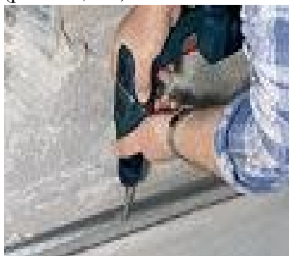
Рис. 2.7. Сверление отверстий под дюбели в полу
