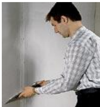
Рис. 2.15. Заделка швов
