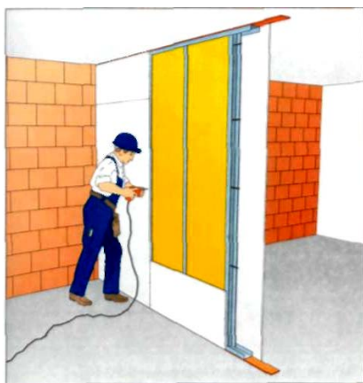
Рис. 2.21. Монтаж гипсокартон-ных листов со второй стороны
