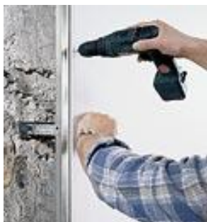
Рис. 2.13. Крепление гипсокартона
