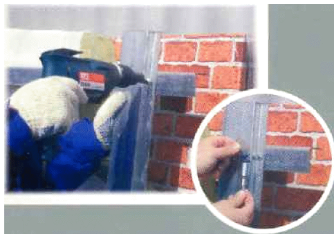
Рис. 3.45. Установка вертикальных шляпных профилей
