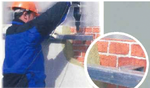
Рис. 3.44. Установка горизонтальных направляющих профилей
