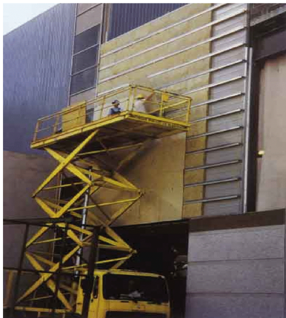
Рис. 3.6. Монтаж теплоизоляции с использованием самоходных подмостей
