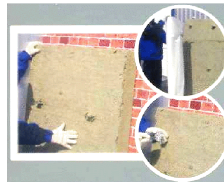
Рис. 3.43 Установка утеплителя
