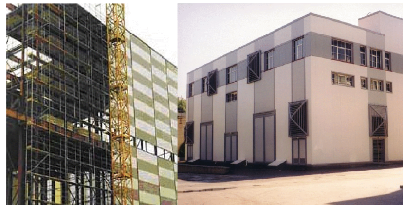
Рис. 3.38. Рабочий момент монтажа и фасад, обустроенный Ruukki Panel
