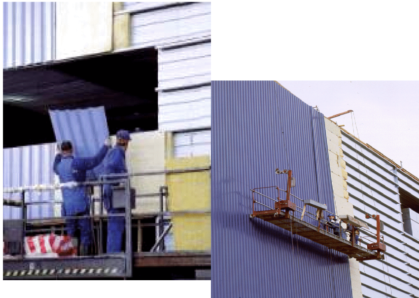
Рис. 3.40. Рабочие моменты монтажа Ruukki Casetti
