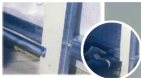
Рис. 3.46. Установка стартовой планки
