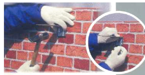
Рис. 3.42. Установка кронштейна
