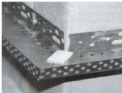
Рис. 3.9. Формирование угла цокольным профилем
