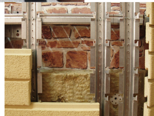
Рис. 3.10. Монтаж панелей облицовки
