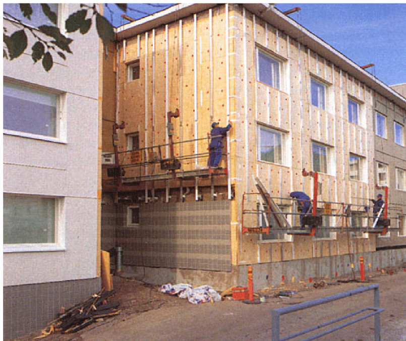
Рис. 3.5. Рабочий момент монтажа фасадной системы с использованием люлек
