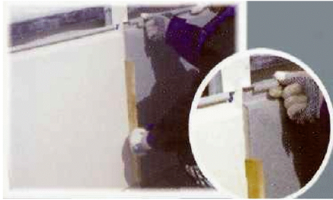
Рис. 3.49. Установка кассеты справа
