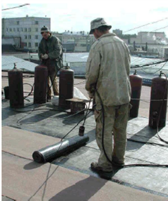
Рис.4.10 Положение рабочего при укладке
