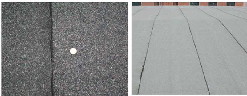
Рис.4.13 Битумно-полимерное вяжущее, вытекшее из-под кромки материала (для сравнения монета 10 коп.)
