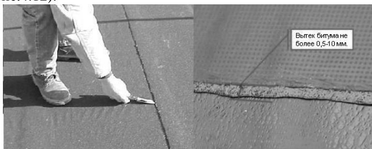
Рис.4.12 Валик расплавленного битумно-полимерного вяжущего
