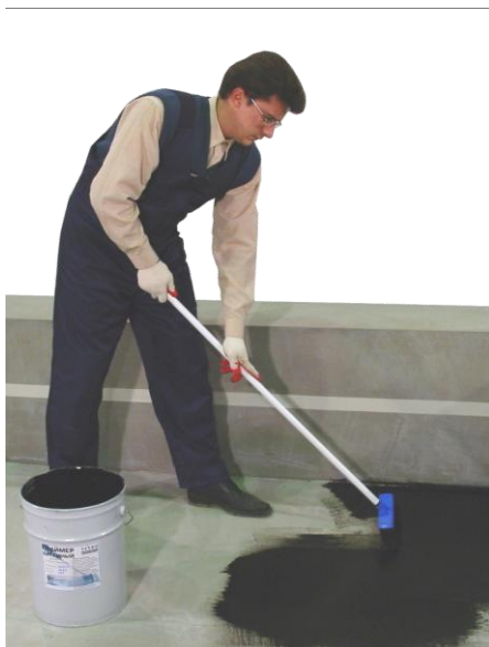
Рис.4.5 Нанесение грунтовки
