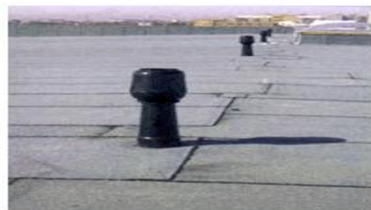
Рис. 4.29 Общий вид кровли с флюгарками
