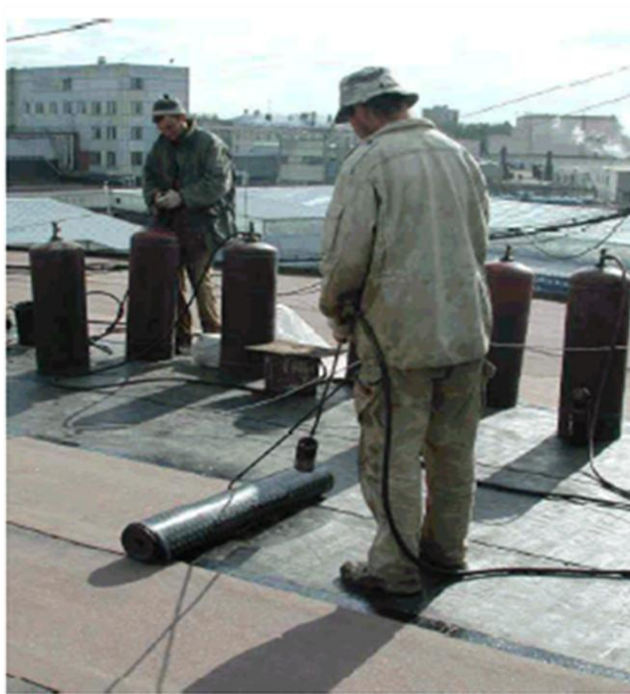
Рис.4.10 Положення робочого при наплавленні СБС матеріалу
