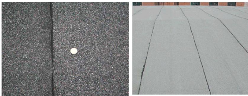
Рис.4.13 Бітумно-полімерне затвердіння, що витекло з-під краю матеріалу (для порівняння монета 10 коп.)
