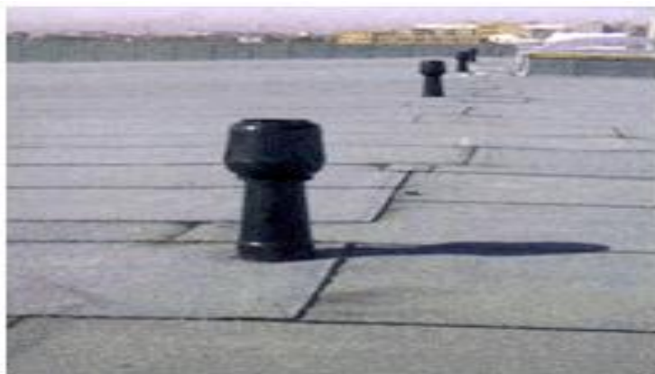
Рис. 4.29 Загальний вид покрівлі з флюгарками
