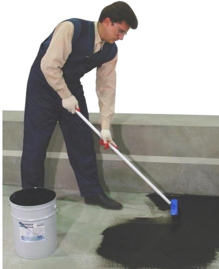
Рис.4.5 Нанесення ґрунтовки
