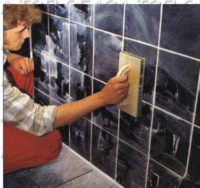
Рис. 2.13. Смывание излишков клеевой смеси
