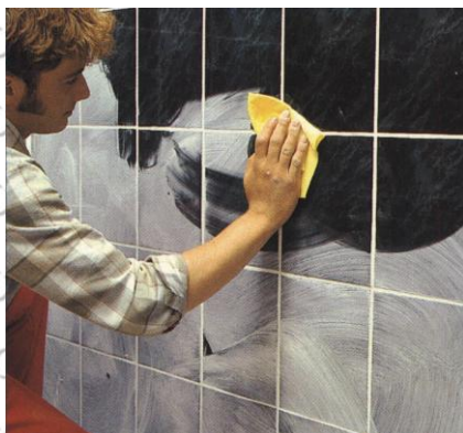
Рис. 2.14. Окончательная очистка плитки водой
