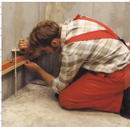
Рис.2.7. Установка горизонтальной рейки
