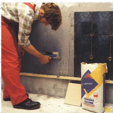
Рис.2.8. Нанесение клеевого раствора
