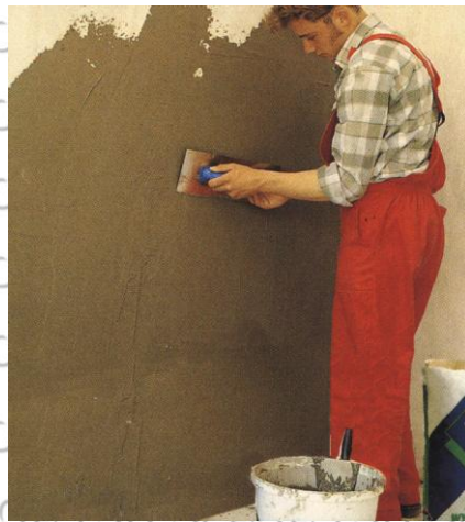
Рис.2.5. . Нанесение второго слоя выравнивающего раствора
