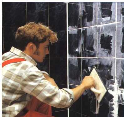
Рис.2.12. Заполнение швов клеевой смесью
