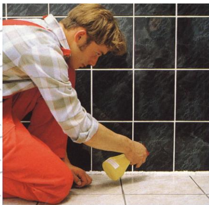
Рис. 2.28. Увлажнение водой силиконовой массы
