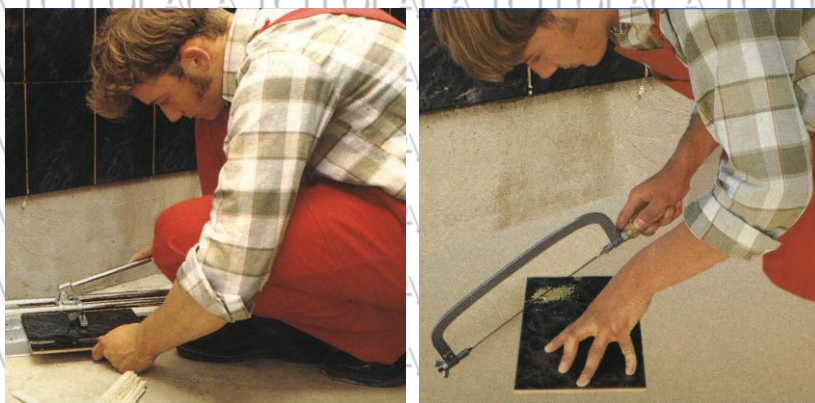
Рис.2.10. Обрезка плитки
