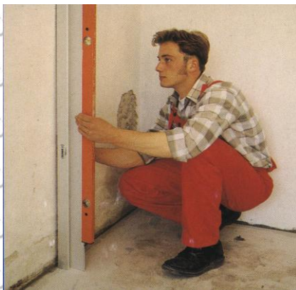
Рис. 2.2. Проверка отклонений поверхности
