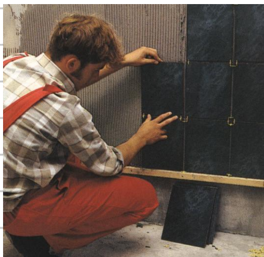
Рис. 2.9. Укладка первых рядов плитки
