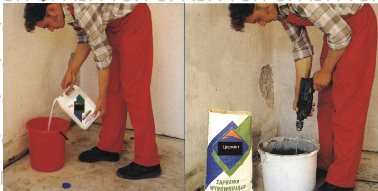
Рис. 2.3. Приготовление растворной смеси.
