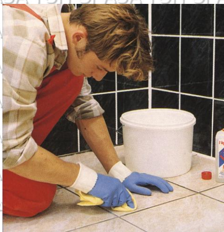
Рис. 2.26. Очистка загрязнённых мест.
