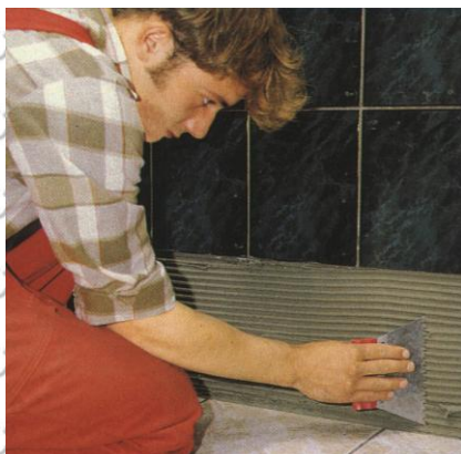
Рис.2.23. Нанесение клеевого раствора на поверхность стены под первый ряд плиток.
