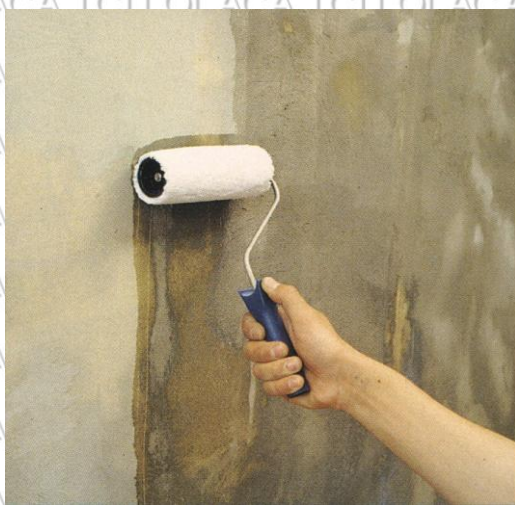
Рис.2.6. Нанесение грунтовочной эмульсии
