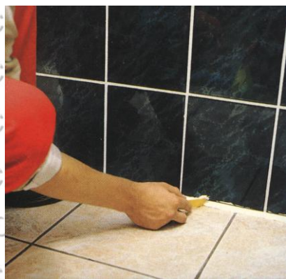
Рис. 2.29. Удаление остатков силикона
