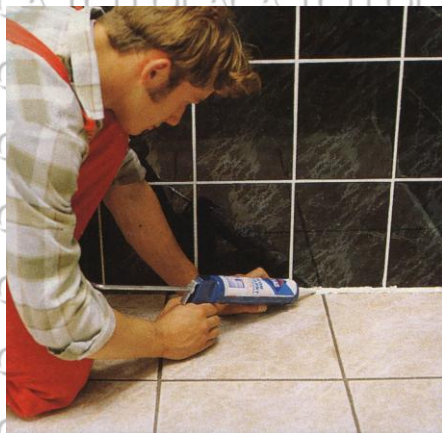
Рис. 2.27. Заполнение швов герметиком.
