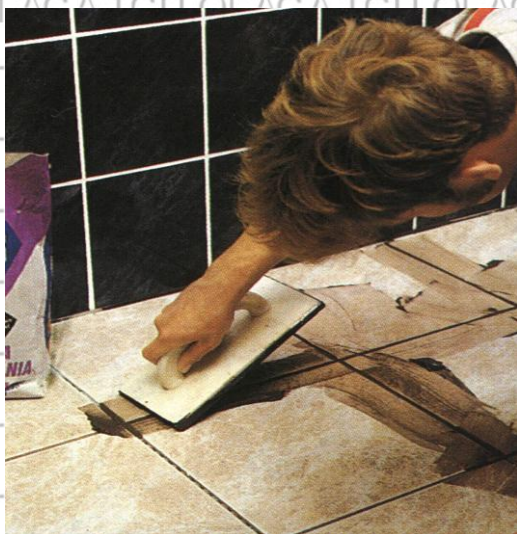
Рис. 2.25. Затирка швов между плитками
