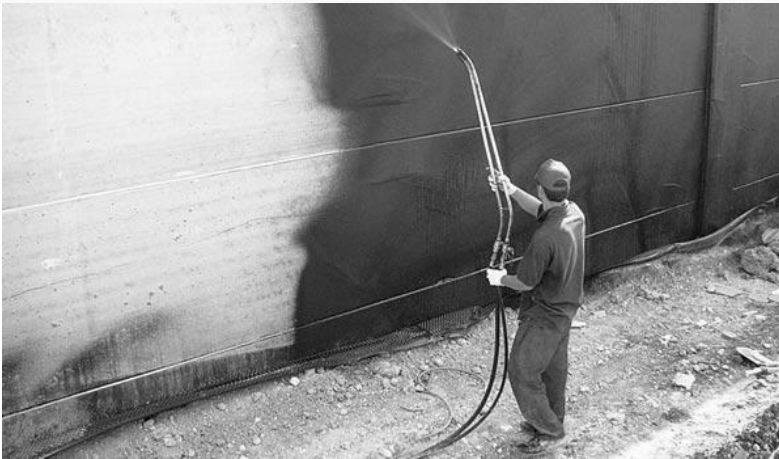
Рисунок 2.10 - Напилення рідкою гумою
