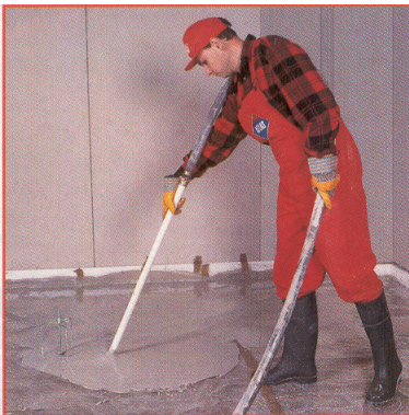
Рис. 1.13. Приготовленная масса выливается смесительно-нагнетательными агрегатами, непрерывно и равномерно распределяется по поверхности до проектных отметок, отмеченных реперами.
