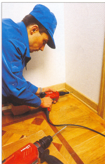
Рис.2.25. Раскрой и крепление плинтусов к стене на шурупы
