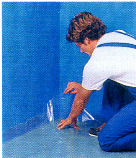
Рис. 2.34. Укладка гидроизолирующей пленки
