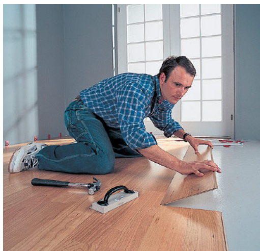
Рис. 2.33. Стыковка панелей методом поворота
