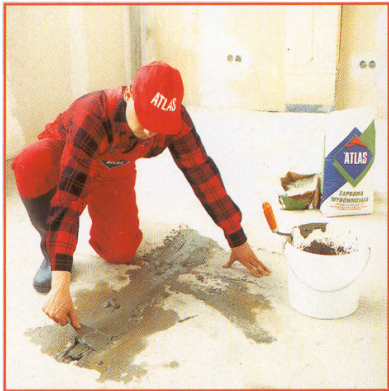
Рис. 1.2. TERPLAN N – тонкослойная выливка, обладающая высокой стоимостью. Поэтому предварительно необходимо выровнять например основание, специальной шпатлевкой. Для этой цели можно использовать специальную выравнивающую смесь ATLAS. Это уменьшает расход TERPLAN N.
