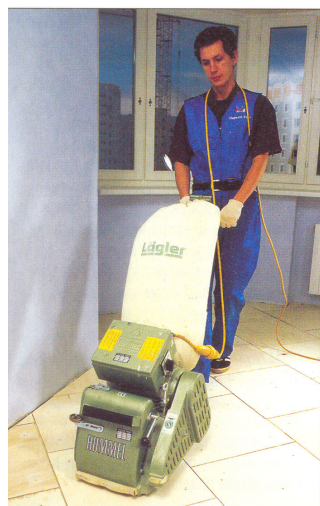
Рис.2.12. Шлифовка фанеры по уровню
