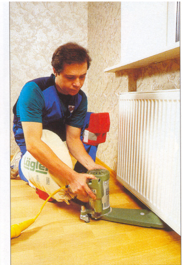
Рис.2.21. Грубая и средняя шлифовка машиной для углов и лестниц
