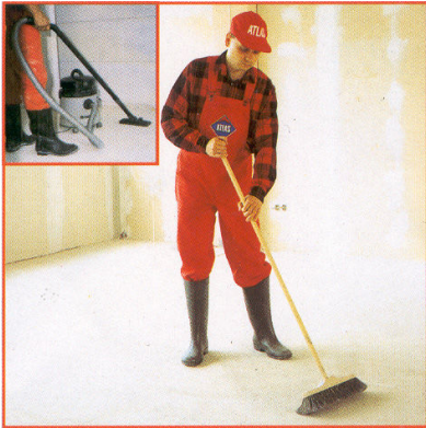
Рис. 1.1. Основание под TERPLAN N должно быть крепким, плотным, чистым. Загрязнения всякого рода, жирные пятна от масел, обветшалые и слабоприлегающие слои удаляются механически, а поверхность пылесосится.
