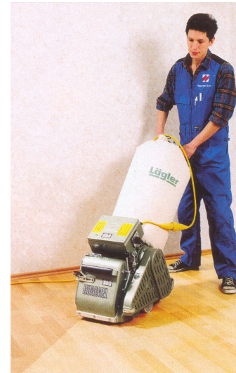
Рис.2.20. Грубая и средняя шлифовка паркета специализированными машинами
