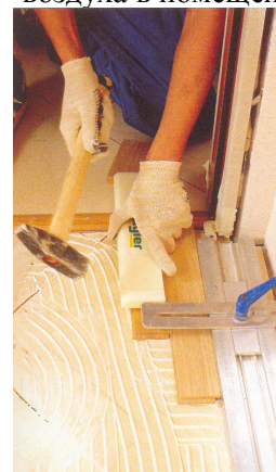
Рис.2.15. Начальный этап укладки штучного паркета с использованием установочного профиля
