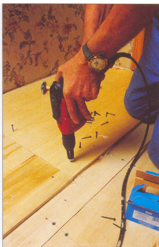
Рис.2.11. Установка фанеры по лагам (крепление второго слоя фанеры на клей и шурупы)
