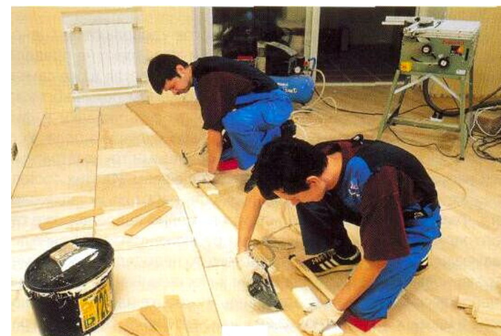
Рис.2.15. Начальный этап укладки штучного паркета с использованием установочного профиля
