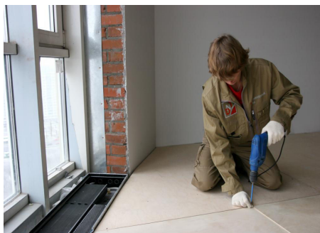
Рис. 1.17. Крепление слоя влагостойкой фанеры
