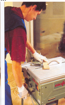
Рис.2.16. Подрезка паркетных планок циркулярной пилой со станиной
