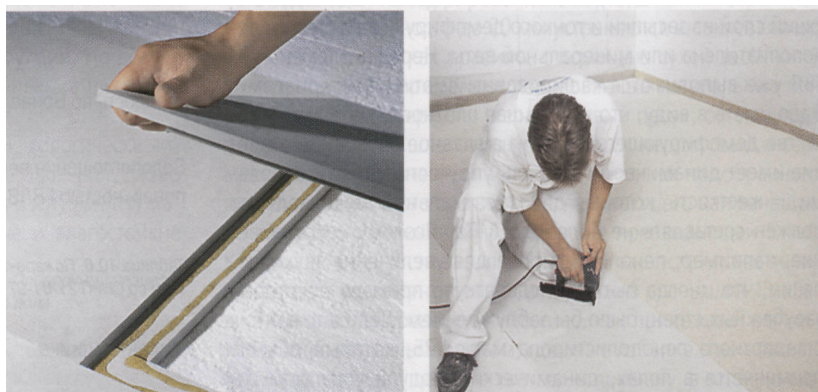
Рис. 1.38. Крепление элементов пола
