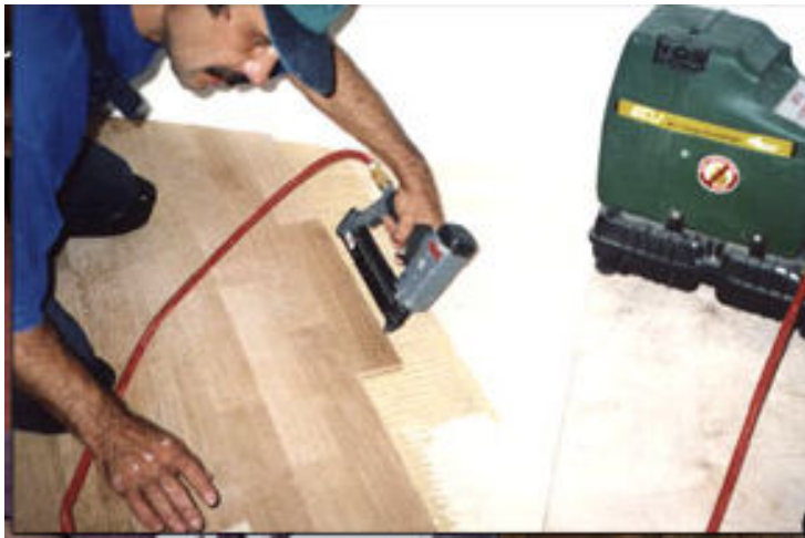
Рис.2.19. Фиксация паркетных планок специальными гвоздями с обжимной головкой, с применением пневматического пистолета
