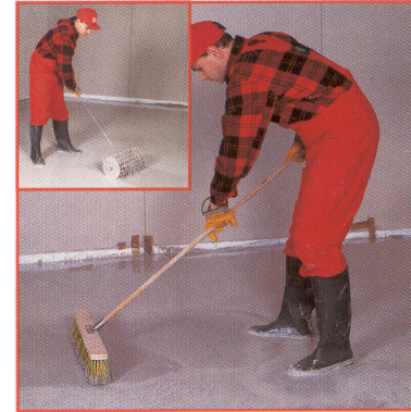
Рис. 1.14. После окончания выливания масса предварительно выравнивается встряхивающими движениями широкой щеткой с твердыми длинными волосами, а также валиком или алюминиевой рейкой.
