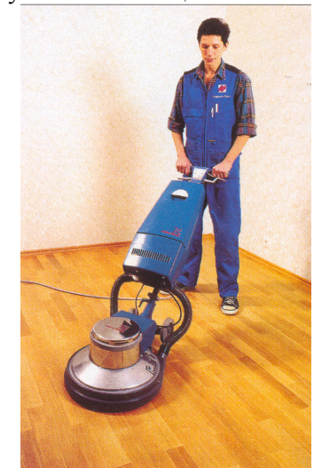
Рис.2.23. Тонкая шлифовка паркета машиной
