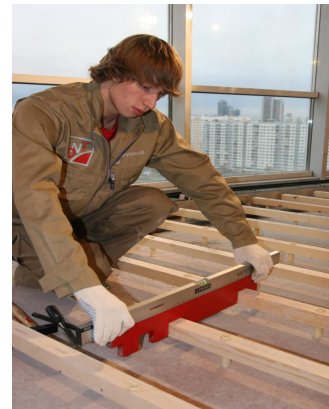
Рис.1.15. Установка лаг
