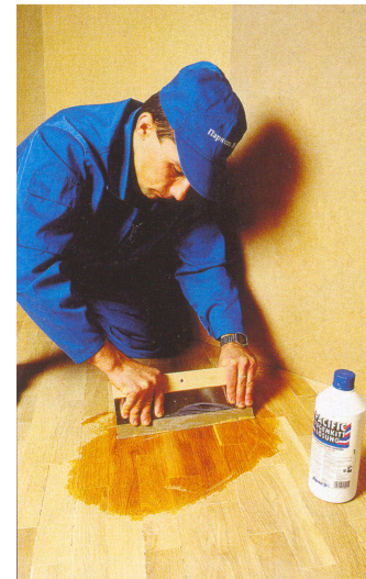
Рис.2.22. Шпаклевка паркета составами на основе древесной пыли
