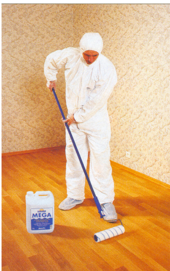
Рис.2.24. Нанесение грунтовочного слоя лака. Нанесение 2-3 слоев основного лака.
