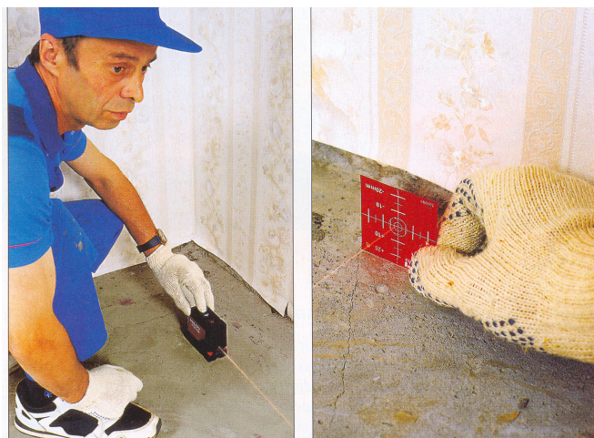
Рис. 2.6. Измерение плоскости и уклона основания лазерным нивелиром
