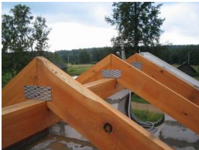
Рис. 2.6. Соединение стропил на коньке
