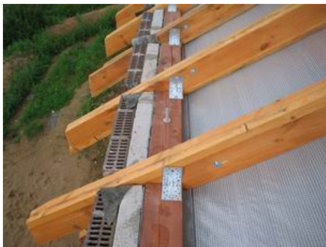
Рис. 2.5. Соединение стропил и мауэрлата
