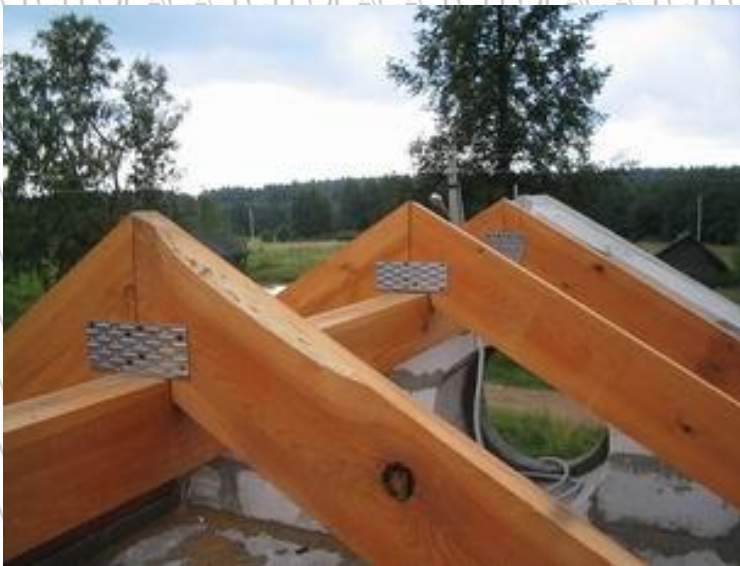
Рис. 2.6. З'єднання крокв на гребені
