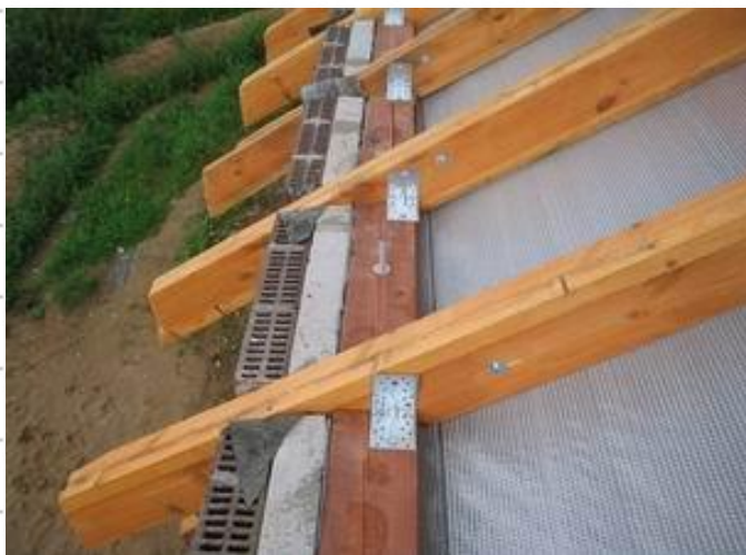
Рис. 2.5. З'єднання крокв і мауэрлата
