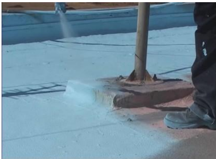
Рис. А.7. Нанесение мастики на места примыканий к проходным отверстиям в кровельном ковре
