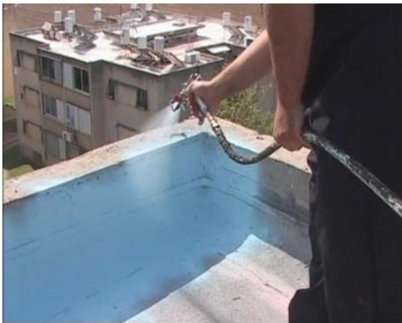
Рис. А.6. Нанесение мастики на места примыканий мастичного кровельного ковра к парапетам
