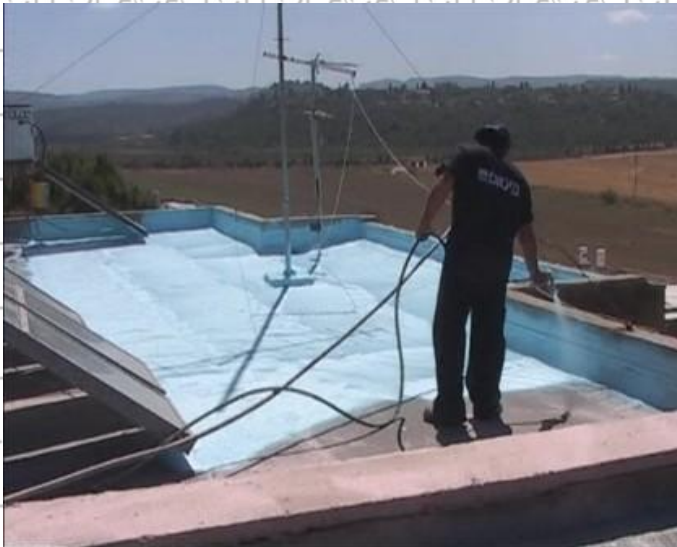
Мал. А.8. Нанесення мастичного покрівельного килима на дах
