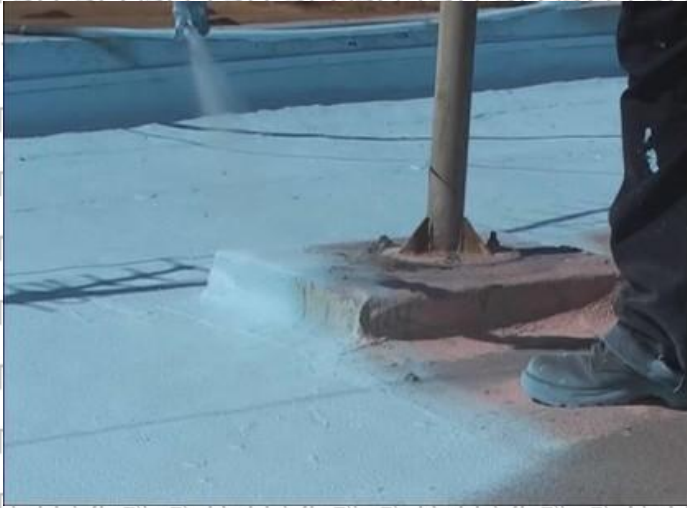
Мал. А.7. Нанесення мастики на місця примикань до прохідних отворів в покрівельному килимі
