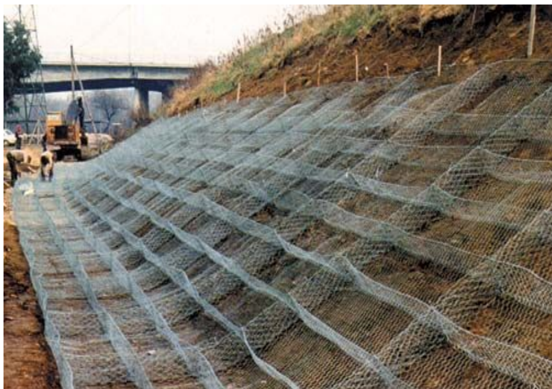
Рис. Б.2.7 Укладання матрасу Рено
