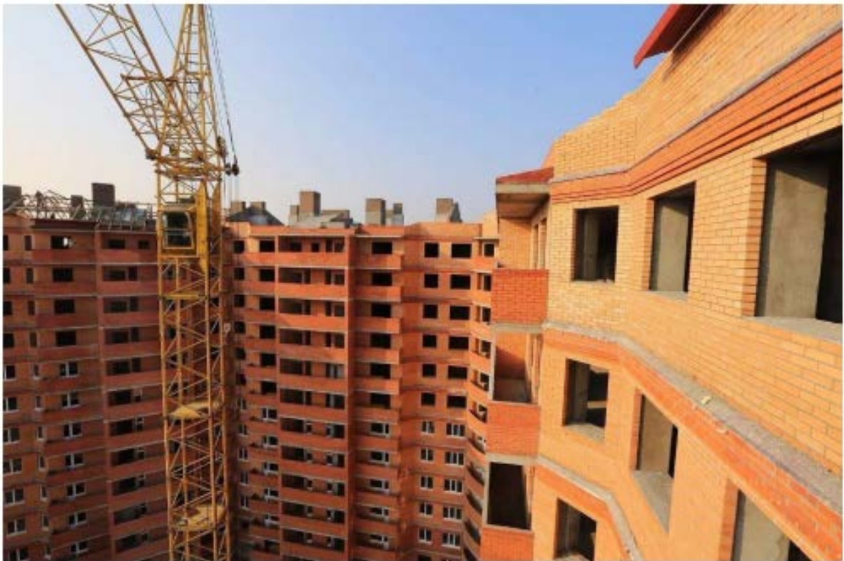
Рис. 10 - Будівництво багатоповерхового цегляного будинку
