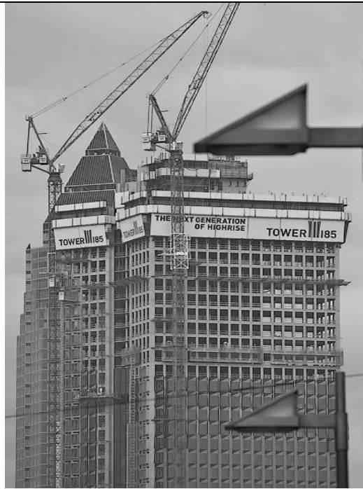
Рис. 4.62. - Процес зведення хмарочосу Майнтауер у Франкфурті-на-Майні (Німеччина) за технологією «вгору-вниз»
