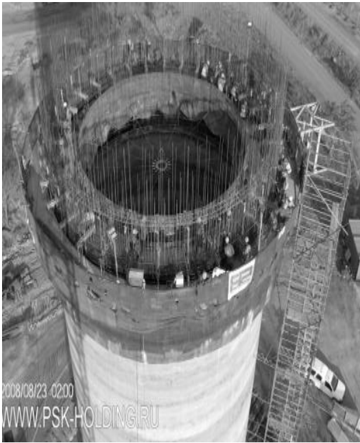
Рис. 4.24- зведення башти в ковзній опалубці
