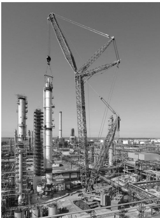
Рис. 4.8. - Зведення баштових споруд укрупненими елементами:
