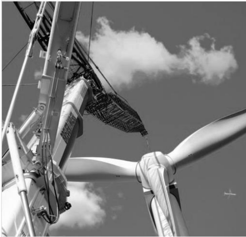
Рис. 4.10 - Зведення баштових споруд вітрогенераторів
