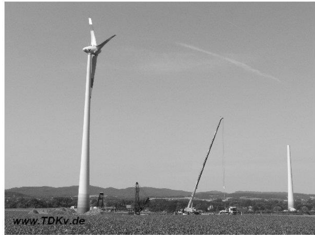
Рис. 4.10 - Зведення баштових споруд вітрогенераторів
