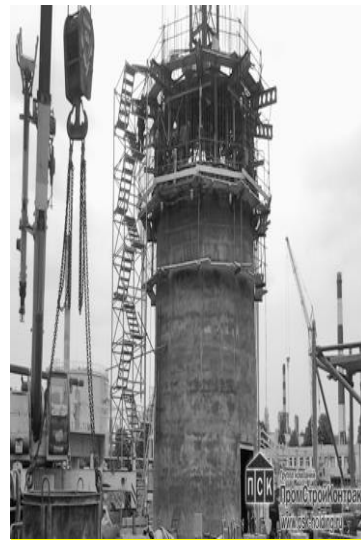
Рис. 4.25. - Будівництво башти в Роттвайлі (Німеччина) в ковзній опалубці
