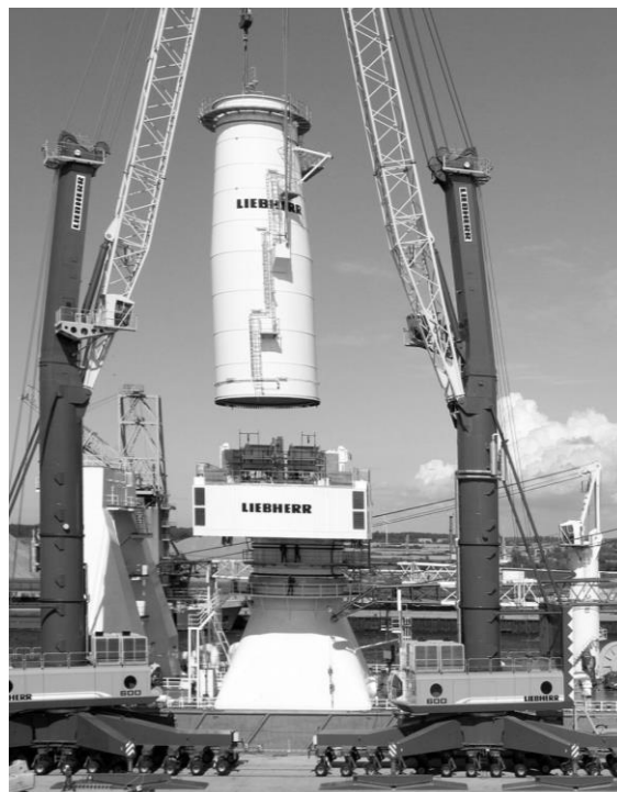
Рис. 4.8. - Зведення баштових споруд укрупненими елементами:
