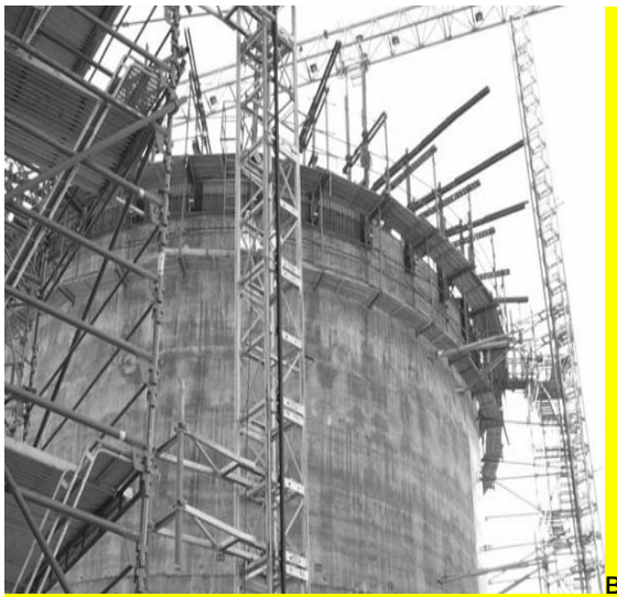
Рис. 4.25. - Будівництво башти в Роттвайлі (Німеччина) в ковзній опалубці
