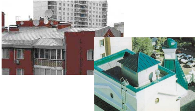
Рис. 2.1. Об'єкти з фальцевою рулонною покрівлею
