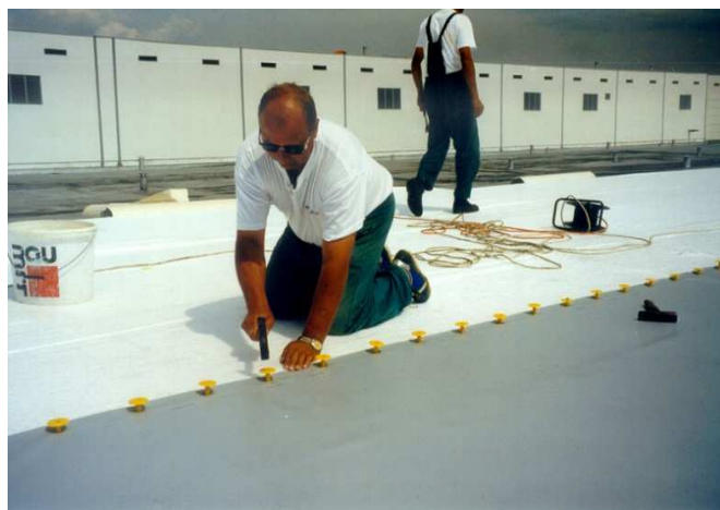
Рис. 3.1 Механічне кріплення полотнищ мембрани до основи
