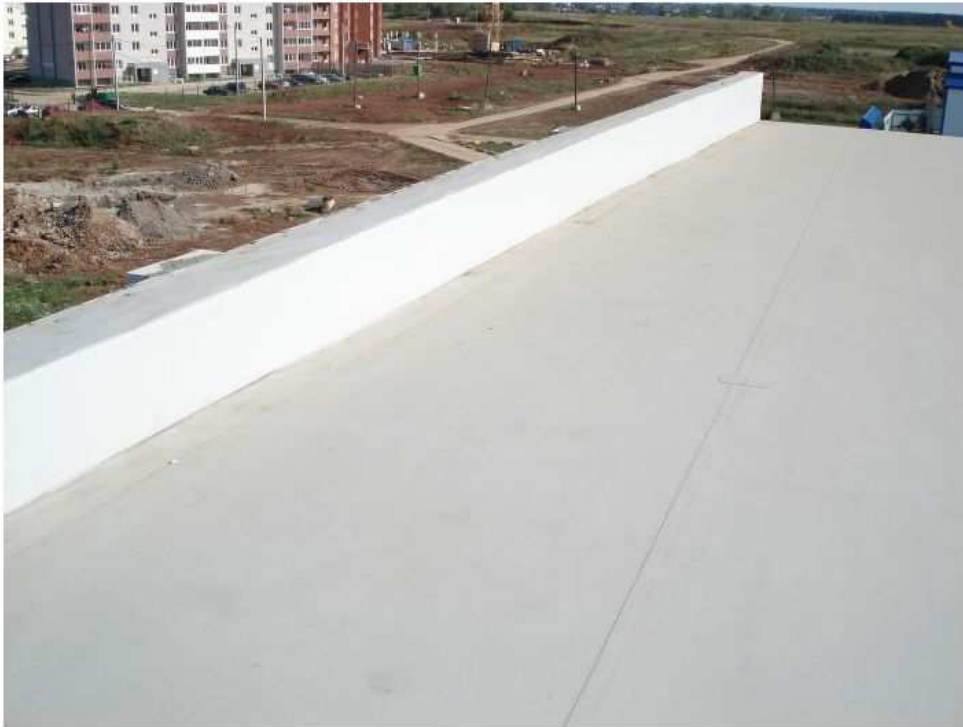
Рис. 3.11 Примикання до парапетів
