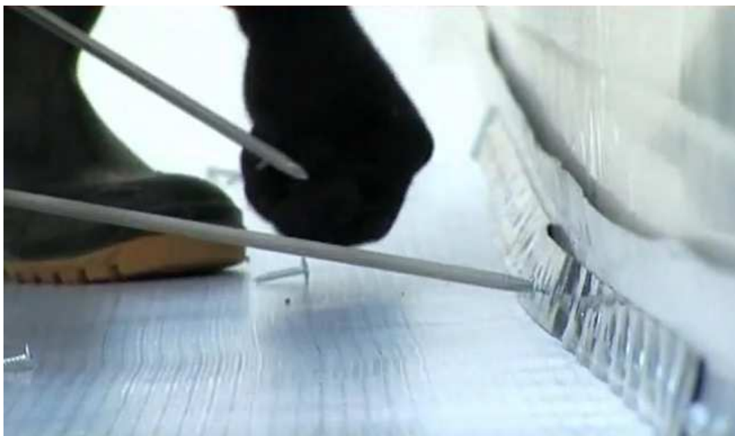
Рис. 3.4 Монтаж притискної планки до парапету
