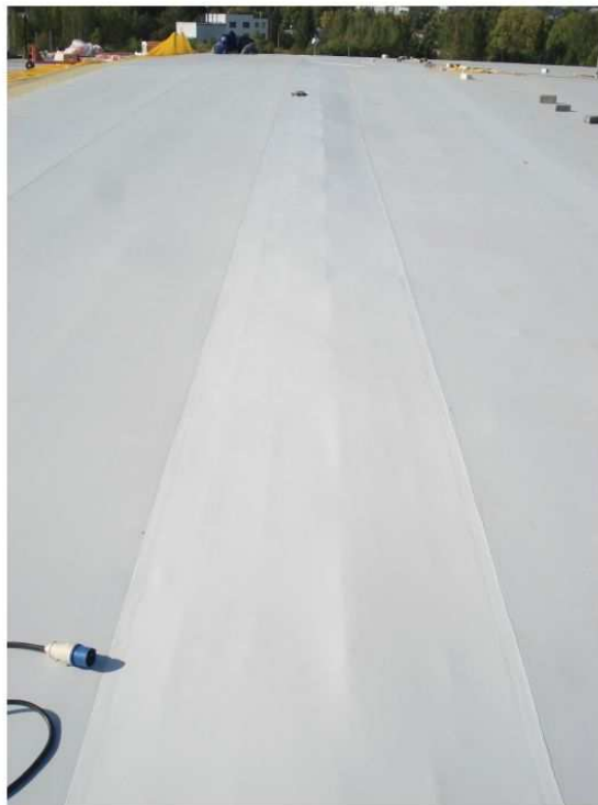
Рис. 3.14. Температурно-усадний шов
