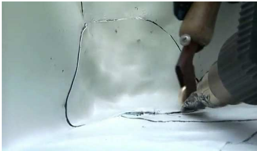
Рис. 3.15. Посилення кутової зони
