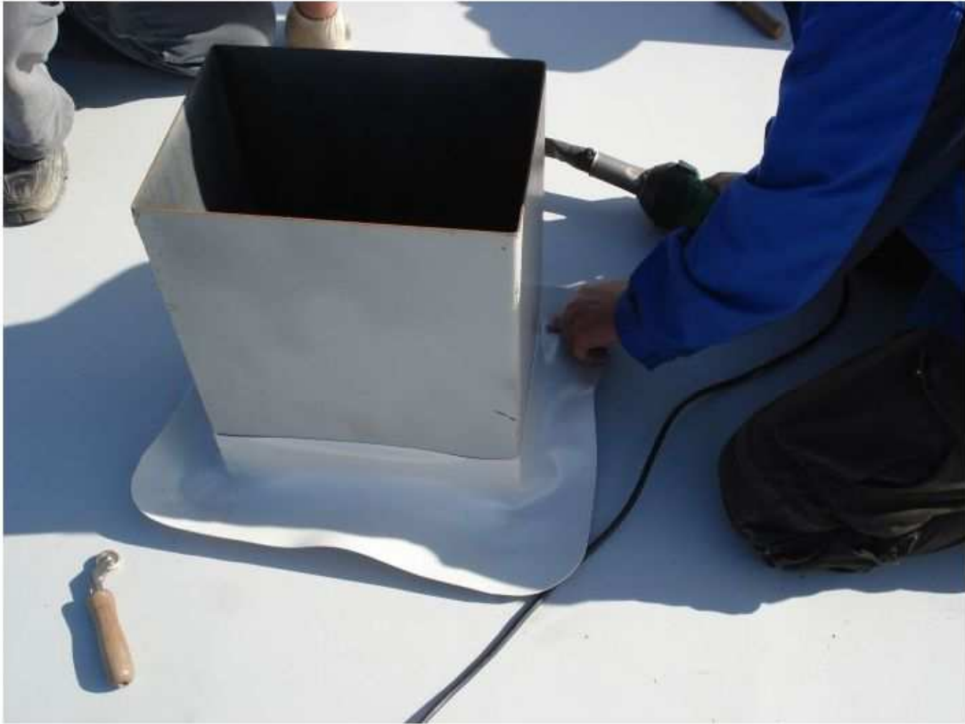
Рис. 3.13 Примикання до вентиляційного повітропроводу
