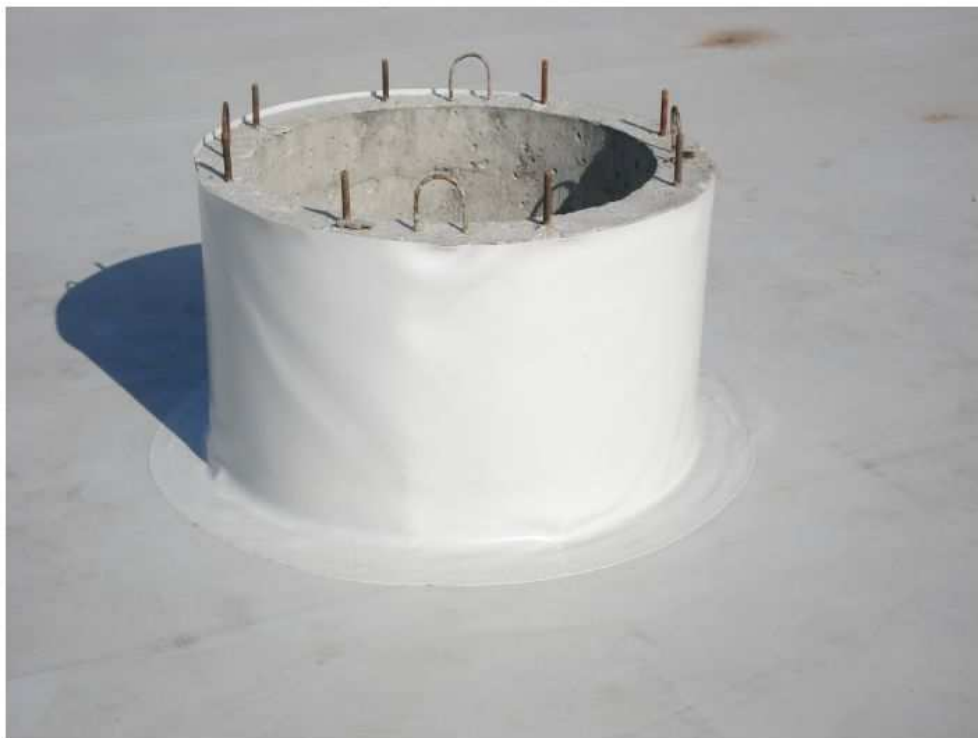
Рис. 3.12 Примикання до вентиляційної шахти
