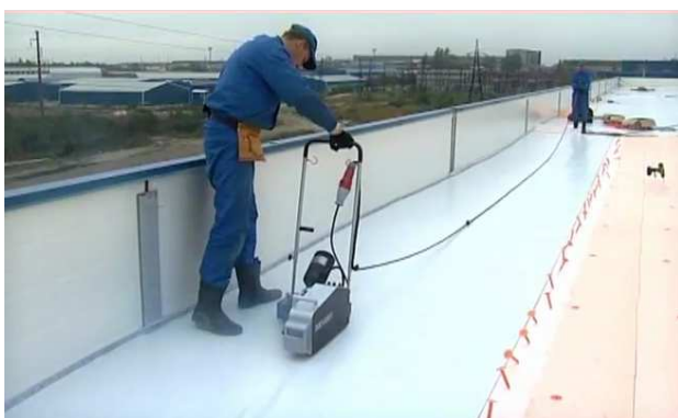
Рис. 3.2 Зварювання полотнищ мембрани зварювальним апаратом
