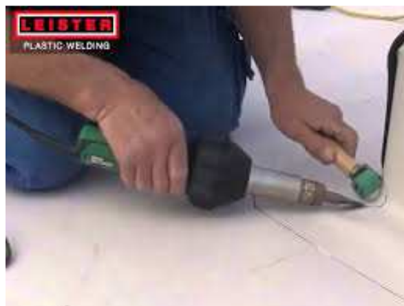
Рис. 1.3 Ручне зварювання
