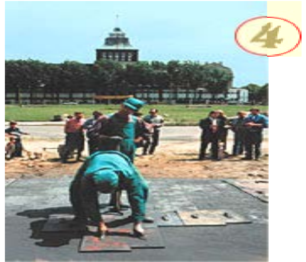
Рис. 1.28. Отжатие при помощи форм соответствующего узора на поверхности свежего бетона.
