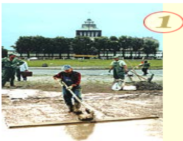
Рис. 1.25. Уплотнение вибрационной рейкой композиционного бетона
