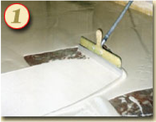
Рис. 1.16. Нанесение и укладка слоя выравнивающей шпаклевочной массы на грунтованное бетонное основание
