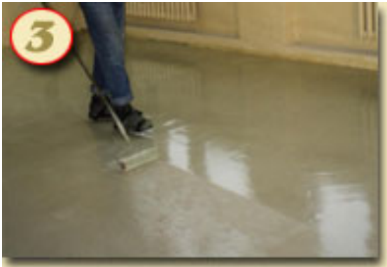
Рис. 1.16. Нанесение и укладка слоя выравнивающей шпаклевочной массы на грунтованное бетонное основание
