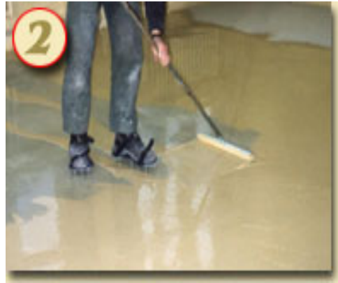
Рис. 1.17. Нанесение и укладка слоя эпоксидной массы для посыпки кварцевым песком
