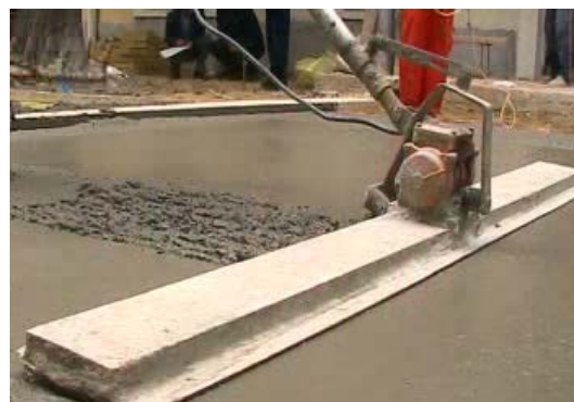
Рис. 1.3. Выравнивание бетонной смеси
