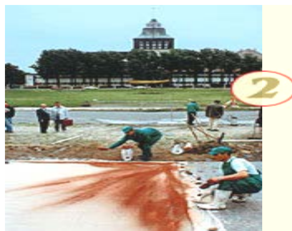
Рис. 1.26. Нанесение цветного отвердителя PRESSBETON - MULTITOP на поверхность свежего бетона
