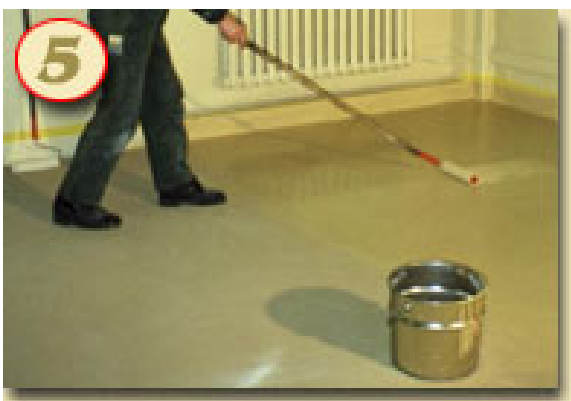
Рис. 1.18. Удаление воздуха с поверхности, подготовленной для посыпки кварцевым песком
