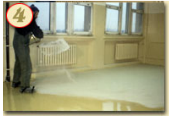
Рис. 1.17. Нанесение и укладка слоя эпоксидной массы для посыпки кварцевым песком
