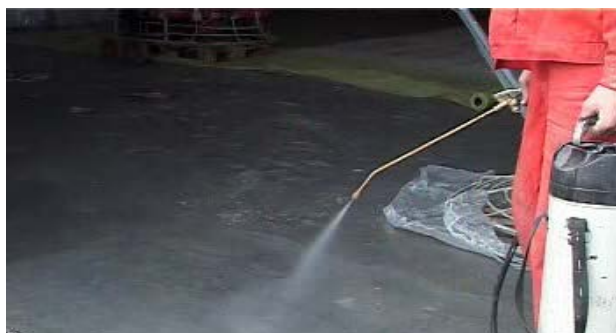
Рис. 1.7. Напыление препарата BAUSEAL
