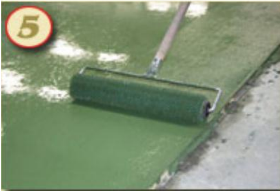
Рис. 1.13. Удаление воздуха из слоя baufloor при помощи валика с иголками
