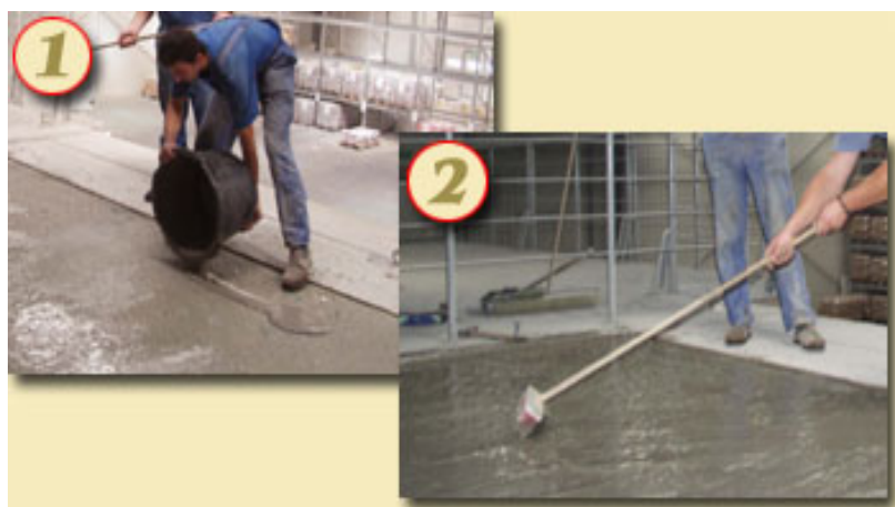
Рис. 1.11. Нанесение препарата BAUBOND.
