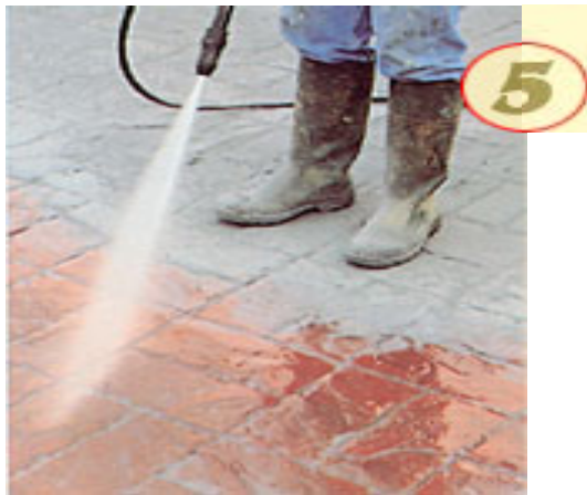
Рис. 1.29. Смывание разделителя струей воды с поверхности застывшего бетона
