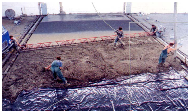
Рис.1.2. Укладка бетонной смеси
