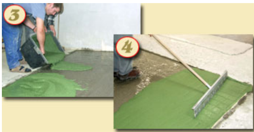
Рис. 1.11. Нанесение препарата BAUBOND.
