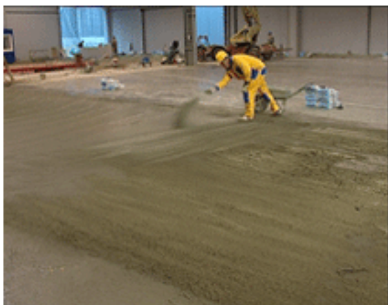
Рис.1.4. Рассыпка отвердителя
