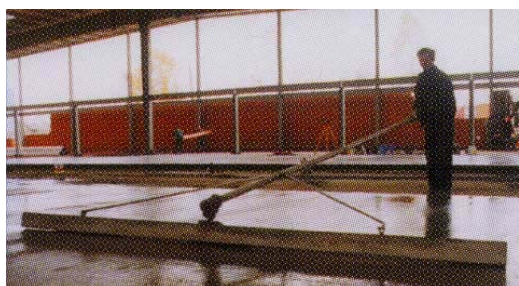
Рис. 1.5. Втирание отвердителя стягивающей рейкой
