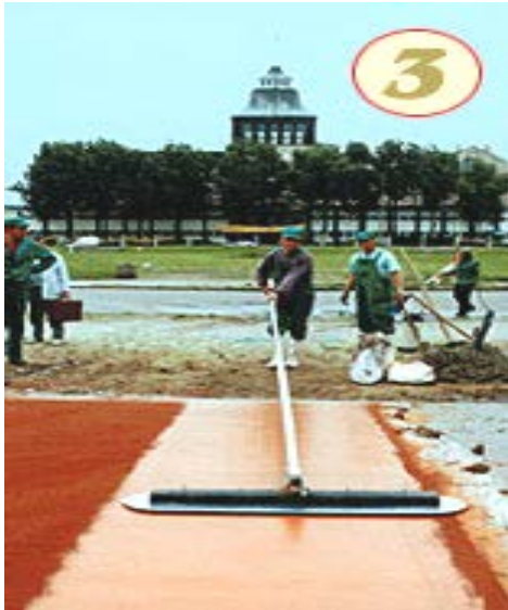
Рис. 1.27. Втирание и разглаживание нанесенного отвердителя стальной тёркой
