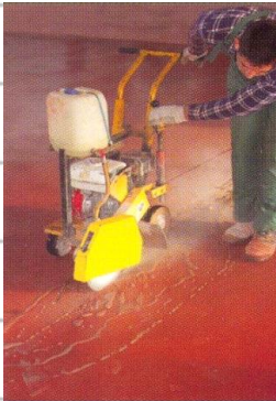
Рис. 1.8. Нарізка усадкових і робочих швів
