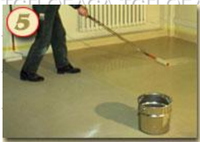
Рис. 1.20. Доопрацювання верхнього шару до насичення
