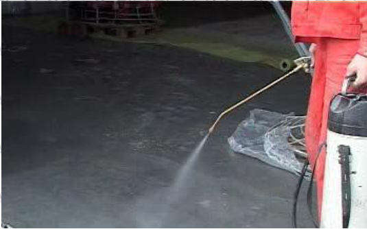
Рис. 1.7. Напилення препарату BAUSEAL
