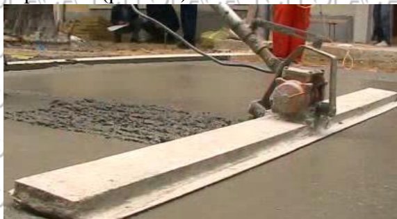
Рис. 1.3. Вирівнювання бетонної суміші
