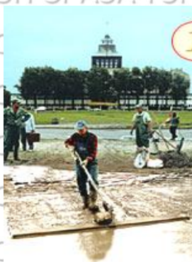
Рис. 1.25. Ущільнення вібраційною рейкою композитного бетону
