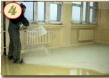
Рис.1.19. Посипання насухо кварцевим піском на підготовлений шар епоксидної маси
