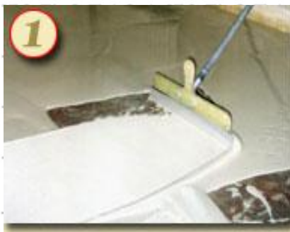
Рис. 1.16. Нанесення і укладання шару вирівнюючої шпаклювальної маси на за-
