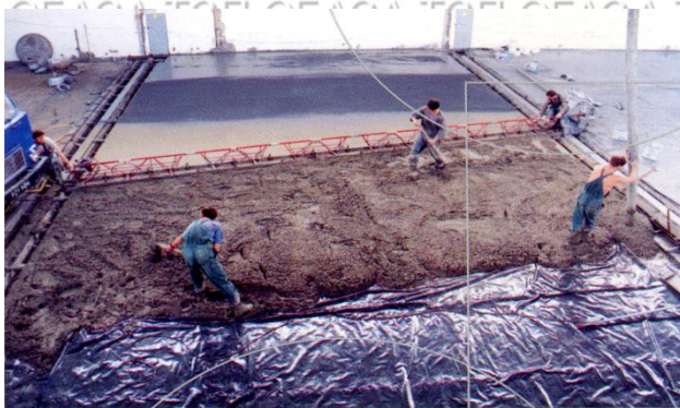
Рис. 1.2. Укладання бетонної суміші
