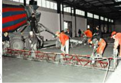
Рис. 2.4. Віброрейка з пневматичним приводом
