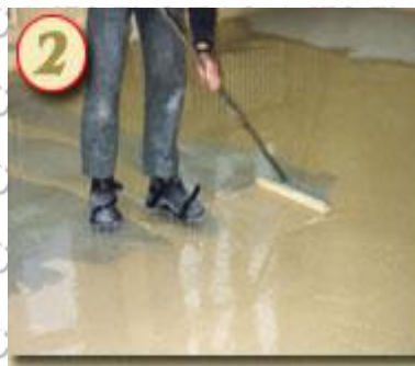
Рис. 1.17. Нанесення і укладання шару епоксидної маси для посипання квар-
