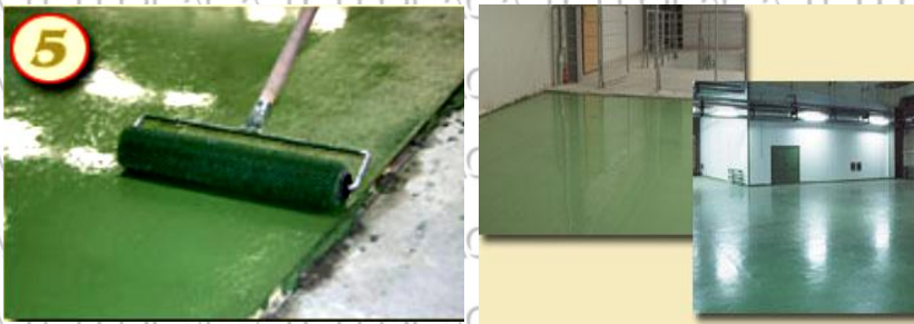
Рис. 1.13. Видалення повітря з шару BAUFLOOR при допомозі валика з голками
