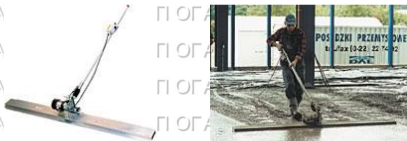
Рис. 2.3. Віброрейка з електроприводом
