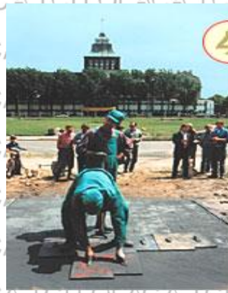
Рис. 1.28. Віджимання за допомогою форм відповідного візерунку на поверхні свіжого бетону.
