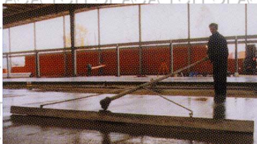
Рис. 1.5. Втирання затверджувача стягуючої рейкою
