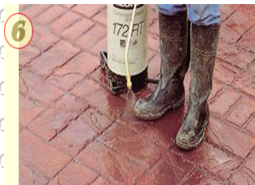
Рис. 1.30. Просочення сухої поверхні акриловим препаратом BAUSEAL додає їй інтенсивний колір і запобігає проникненню води, масел, мастил в тіло бетону.
