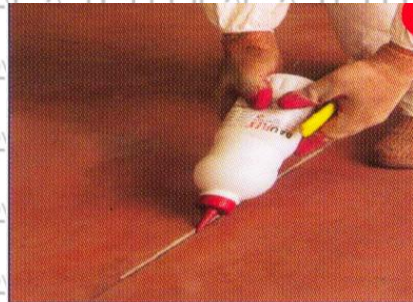
Рис. 1.9. Заповнення швів масою BAUFLEX
