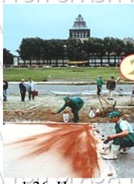
Рис. 1.26. Нанесення кольорового отвердживача PRESSBETON - MULTITOP на поверхню свіжого бетону
