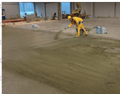
Рис. 1.4. Розсіпка затверджувача
