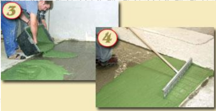
Рис. 1.12. Укладання шару BAUFLOOR за допомогою ручної сталевій рейки.
