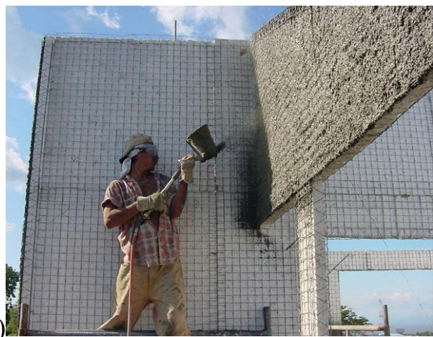
Рис.2.3. Хопер-розпилювач із компресорною станцією а) загальний вид; б) нанесення на поверхню
