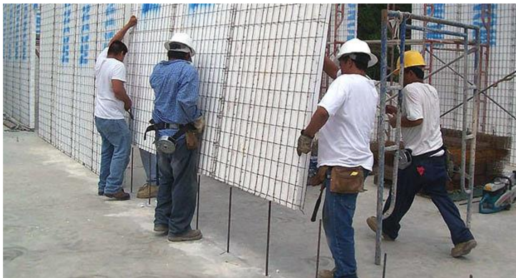
Рис.2.2. Монтаж панелей
