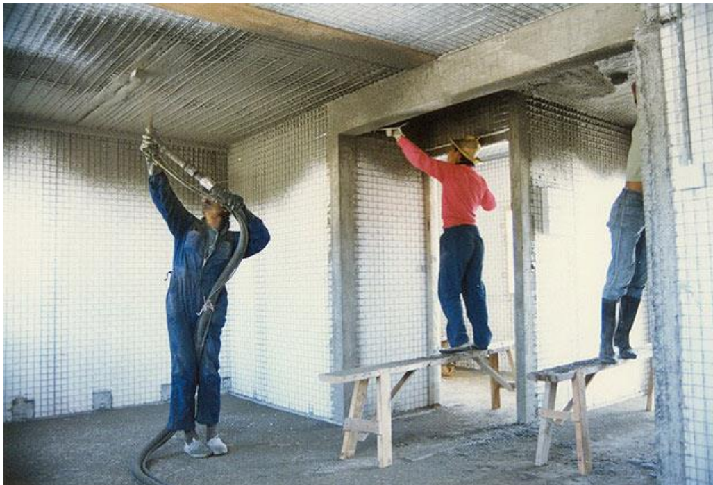
Рис.2.4. Застосування штукатурної станції
