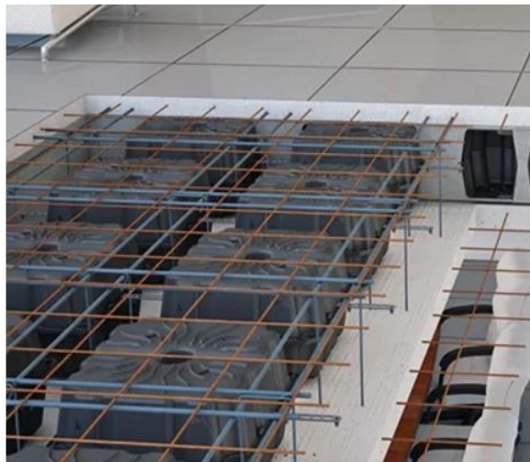
Рис. 2.13. Розміщення модулів і верхнього шару сітки
