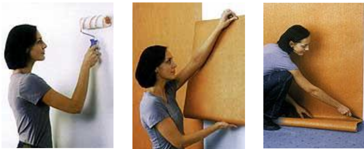
Рис. 7.1 – Етапи наклеювання флізелинових шпалер
