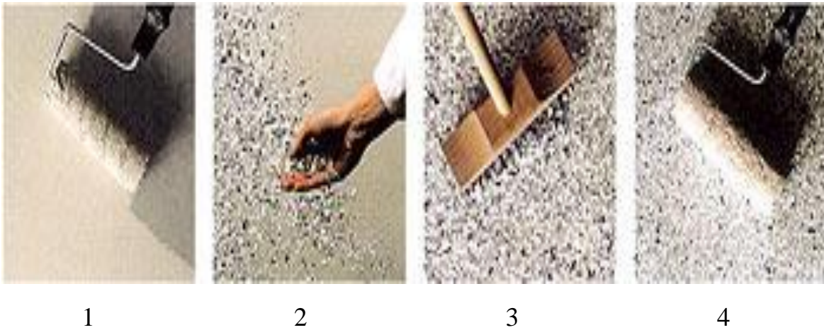
Рис. 5.2 – Техніка нанесення «флока»: 1 – нанесення склеювального шару; 2–3 – нанесення акрилових частинок; 4 – нанесення шару лаку
