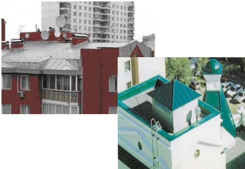
Рис.7.3 – Об'єкти з фальцевою рулонною покрівлею
