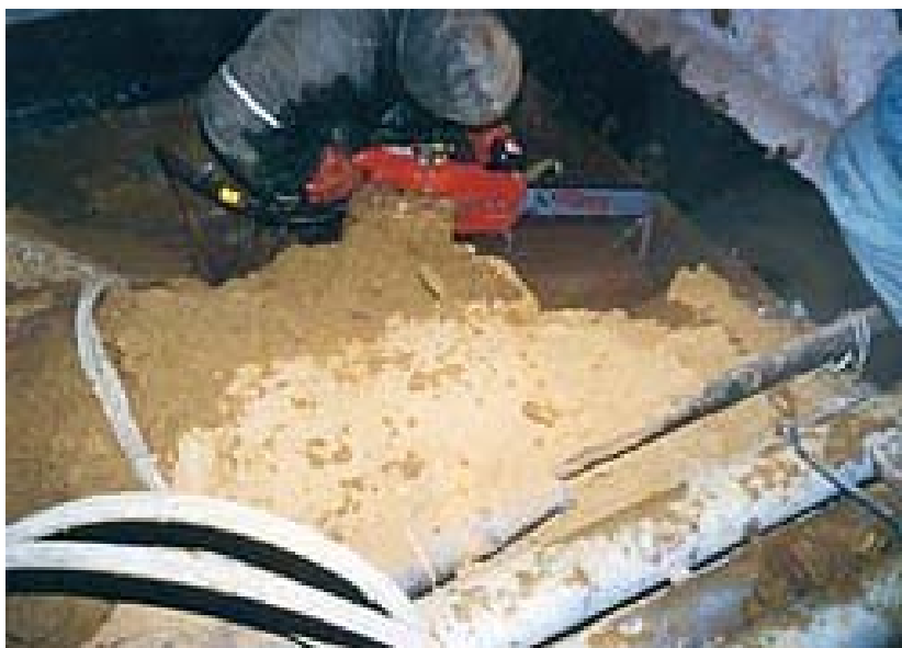
Рис. 9. Пропилювання прорізів для домкратів.
