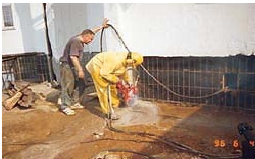
Рис. 10. Пропилювання прорізів для домкратів..
