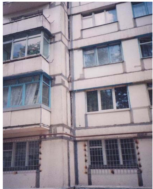
Рис. 3 Розрив зовнішньої і внутрішньої стіни.
