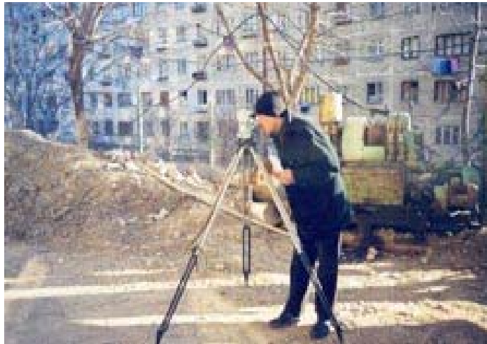
Рис. 15. Геодезичний контроль процесу підйому будівлі.
