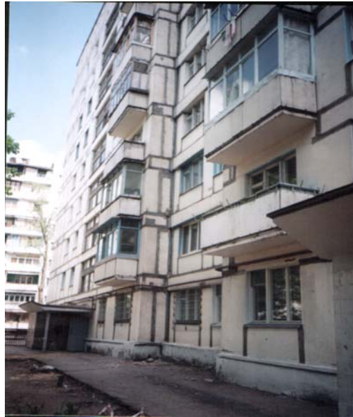
Рис. 2 Фрагмент фасаду будівлі по вул. Гудименка, 17
