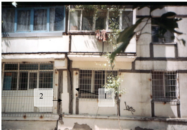
Рис. 7. Фрагмент утворення штучного осадового шва неправильної форми.
