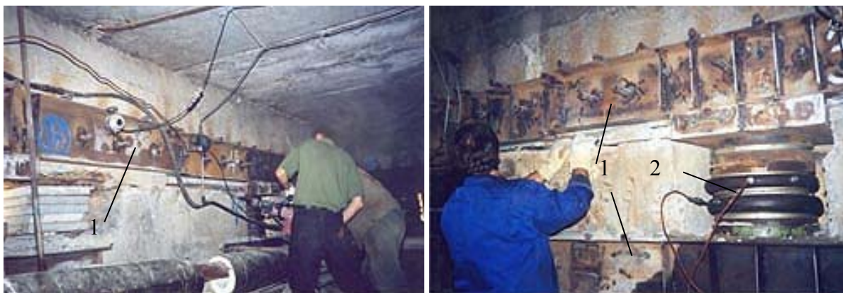
Рис. 11. Установка домкратів в домкратні ніші:
