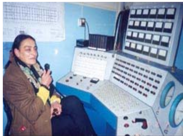
Рис. 17. Пульт управління системою вирівнювання будівлі.
