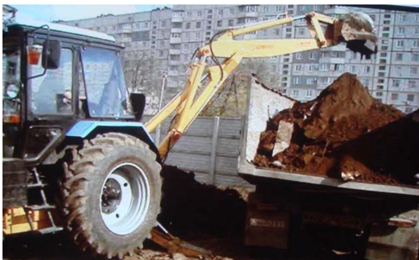
Рис. 8. Навантаження асфальту і ґрунту екскаватором.
