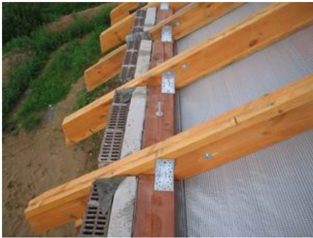
Рисунок 3.2 – Приклади використання цвяхових пластин: а – кріплення крокв і мауерлату; б – сполучні цвяхові пластини на коньку
