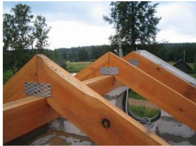
Рисунок 3.2 – Приклади використання цвяхових пластин: а – кріплення крокв і мауерлату; б – сполучні цвяхові пластини на коньку
