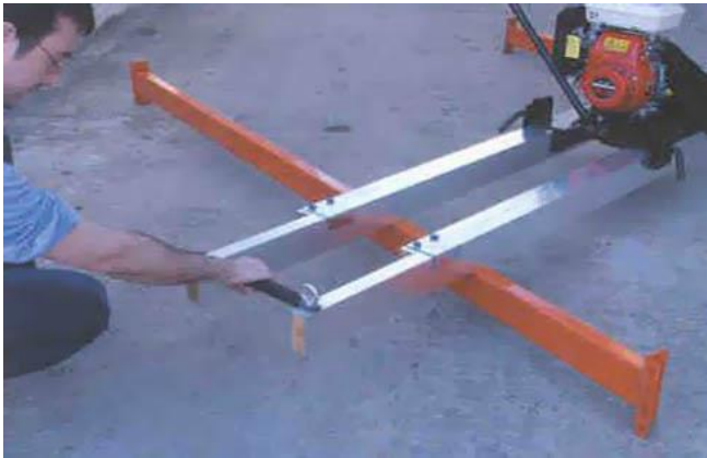
Рис. 23. Фрагмент ущільнення бетону за допомогою віброрейки
