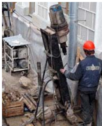
Рис. 17. Фрагмент занурення ін'єктора
