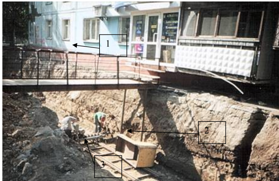
б) процес буріння свердловин під будівлею для вирівнювання крену
