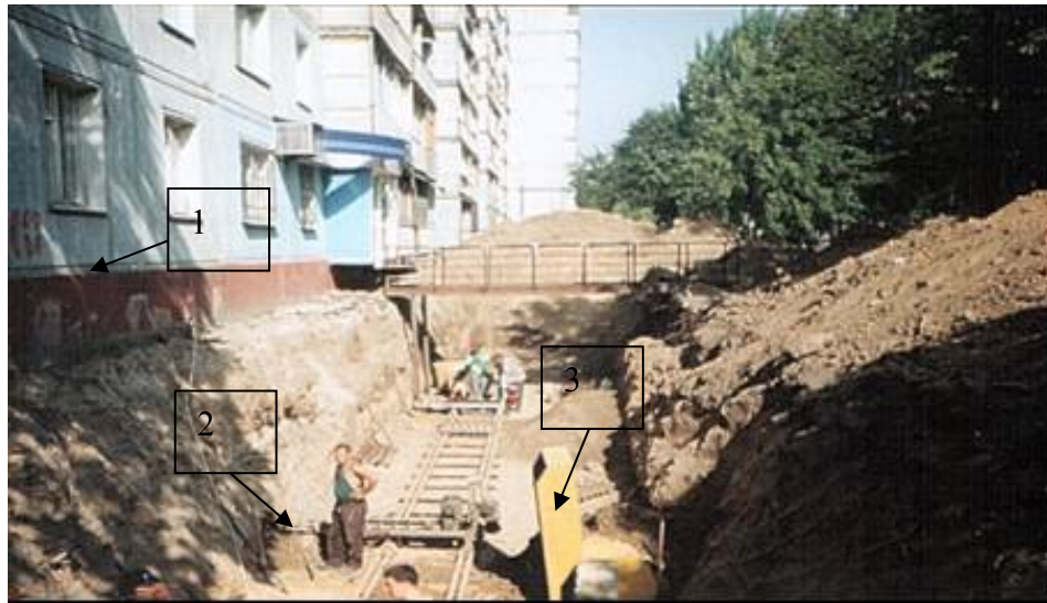
а) монтаж установка
