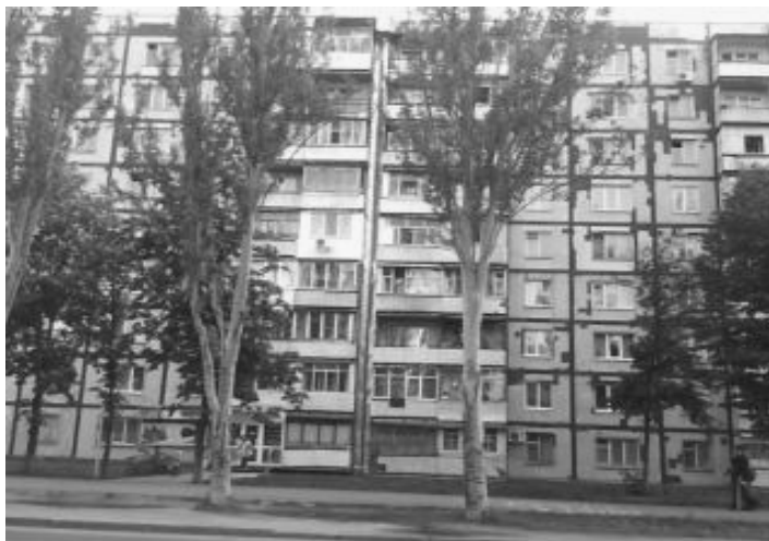
Рис. 18. Житлова будівля по вул. Гудименка 17 після вирівнювання крену.
