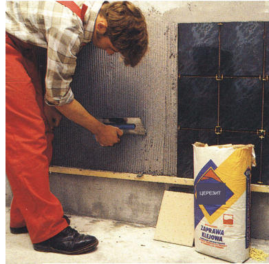
Рис.2.8 – Нанесення клейового розчину
