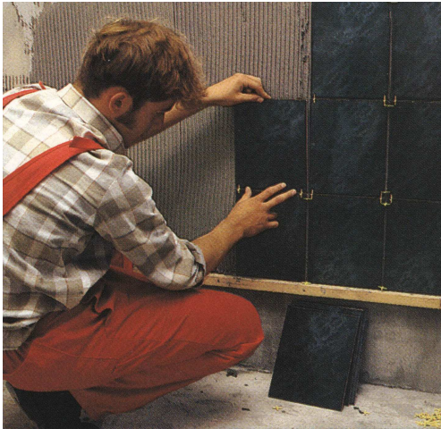
Рис. 2.9 – Укладання перших рядів плитки
