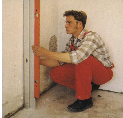
Рис. 2.2 – Перевірка відхилень поверхні
