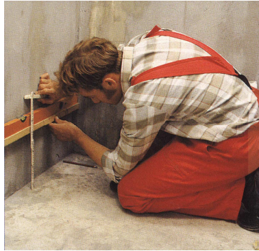
Рис.2.7 – Установка горизонтальної рейки
