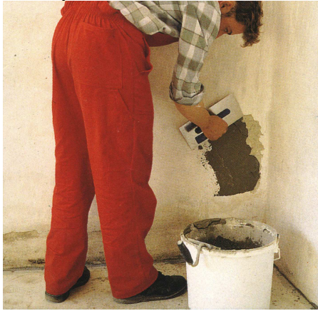
Рис. 2.4 – Нанесення першого шару вирівнюючого розчину
