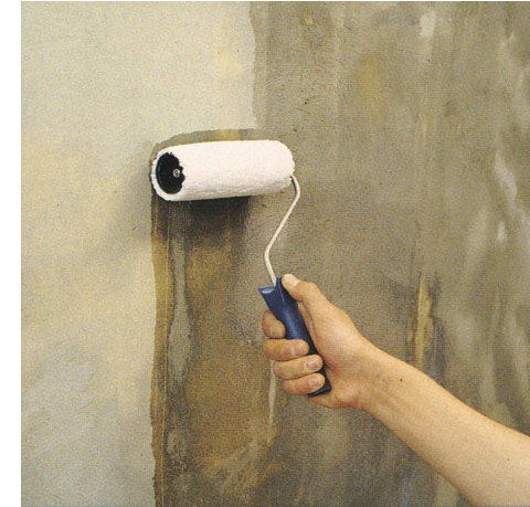
Рис.2.6 – Нанесення емульсії ґрунтовки
