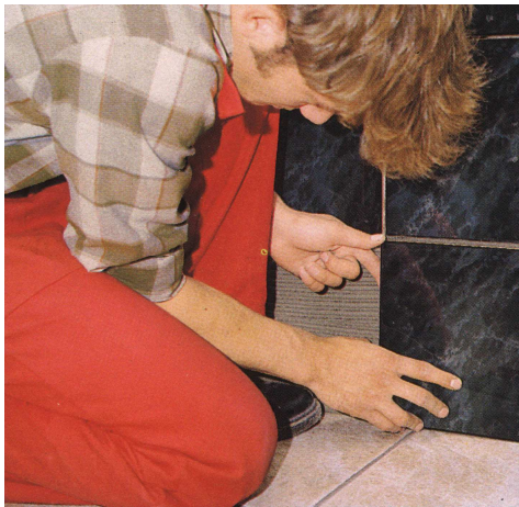
Рис. 2.24 – Укладання цокольного ряду плиток.
