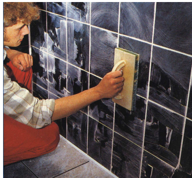
Рис. 2.13 – Змивання надлишків клейової суміші
