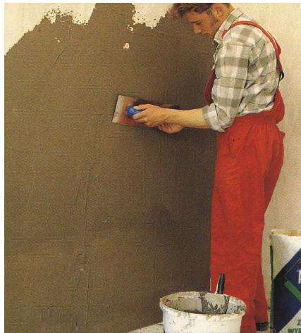
Рис.2.5. . Нанесення другого шару вирівнюючого розчину
