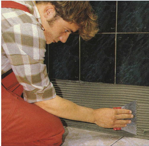
Рис.2.23 – Нанесення клейового розчину на поверхню стіни під перший ряд плиток.
