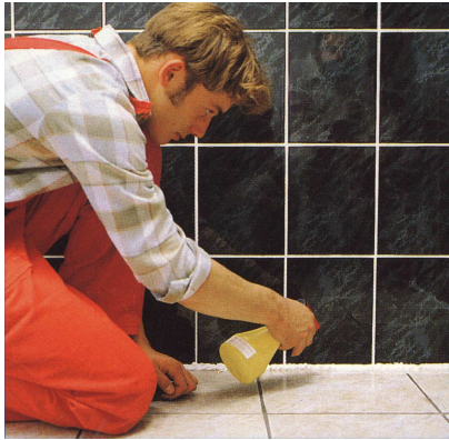
Рис. 2.28 – Зволоження водою силіконової маси
