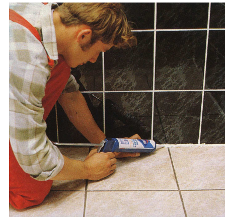
Рис. 2.27 – Заповнення швів герметиком.
