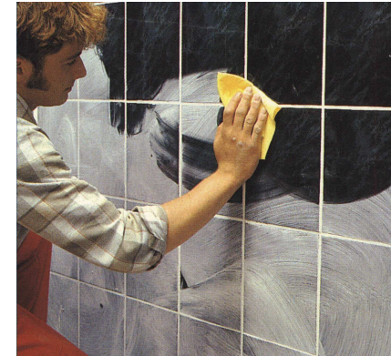
Рис. 2.14 – Остаточне очищення плитки водою
