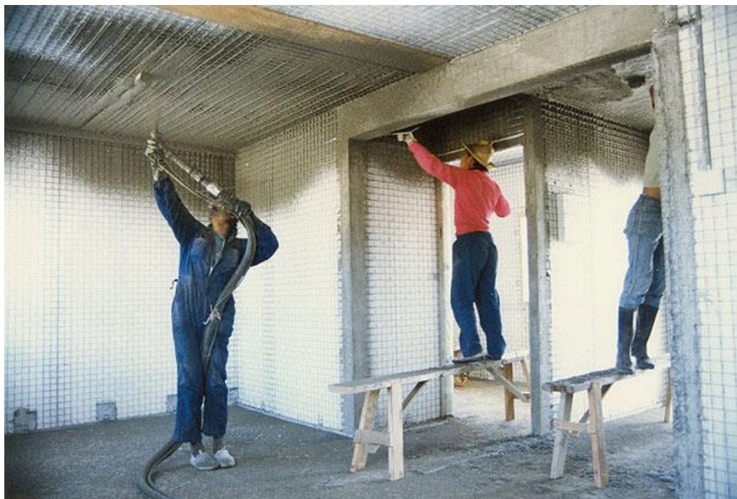
Рис.2.4. Застосування штукатурної станції
