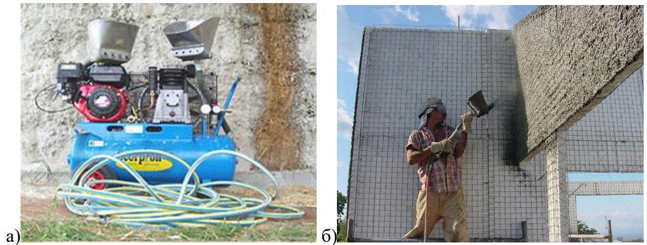
Рис.2.3. Хопер-розпилювач із компресорною станцією а) загальний вид; б) нанесення на поверхню
