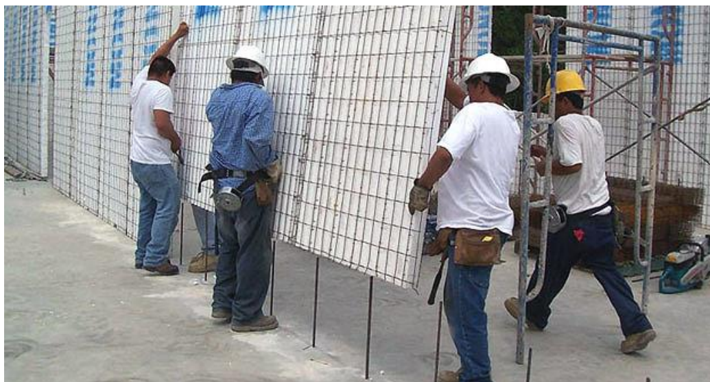
Рис.2.2. Монтаж панелей
