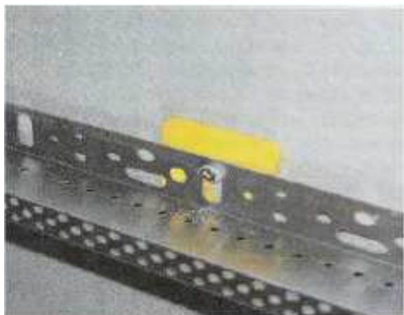
Рис. 3.8. Установка сполучних елементів і підкладкових шайб
