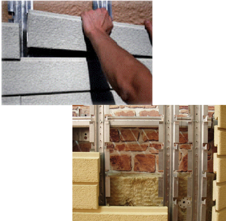
Рис. 3.10. Монтаж панелей облицювання
