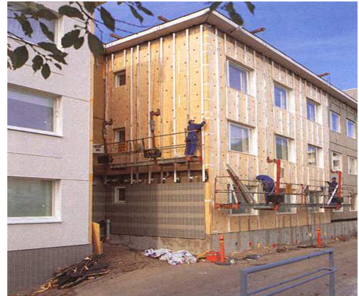
Рис. 3.5. Робочий момент монтажу фасадної системи з використанням колісок
