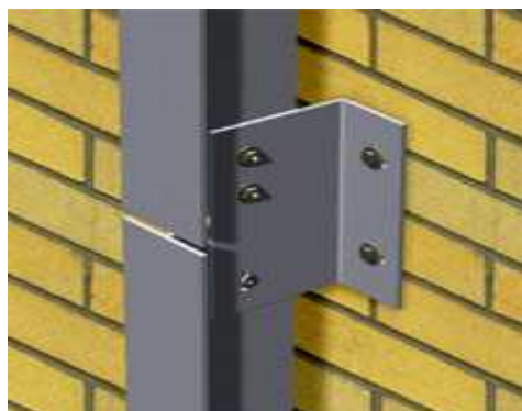
Рис. 1.4. Монтаж направляючих
