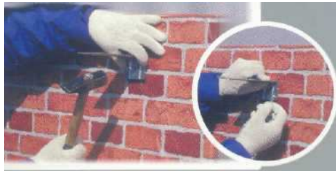
Рис. 3.42. Установка кронштейна
