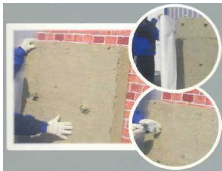
Рис. 3.43 Установка утеплювача
