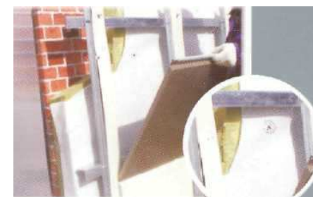
Рис. 3.50. Установка касети зверху
