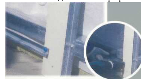
Рис. 3.46. Установка стартовой планки
