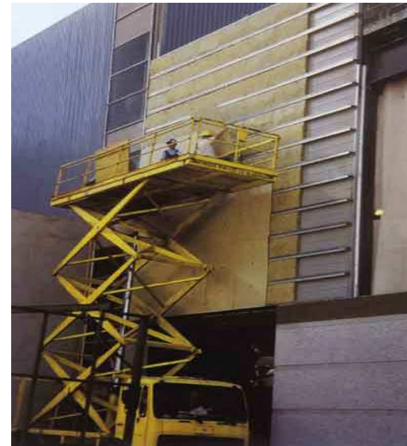
Рис. 3.6. Монтаж теплоізоляції з використанням самохідних підмостей
