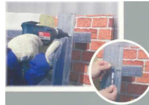
Рис. 3.45. Установка вертикальных шляпных профилей
