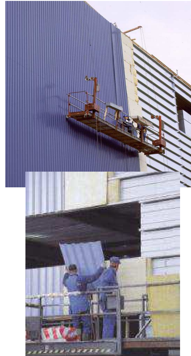
Рис. 3.40. Робочі моменти монтажу Ruukki Casetti
