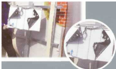
Рис. 3.47. Видалення плівки з поверхні касети
