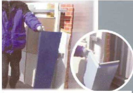
Рис. 3.51. Установка добірних елементів
