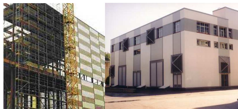
Рис. 3.38. Робочий момент монтажу і фасад, який обладнаний Ruukki Panel
