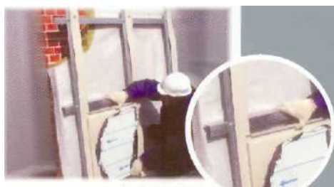
Рис. 3.48. Монтаж касети на стартову планку
