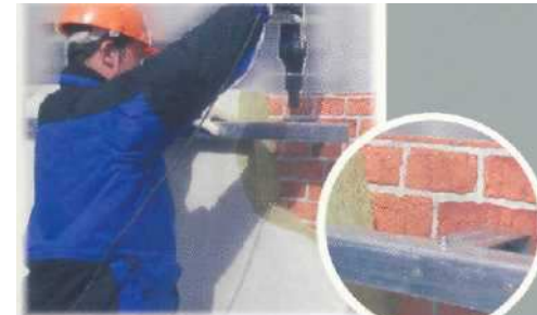
Рис. 3.44. Установка горизонтальных направляющих профилей
