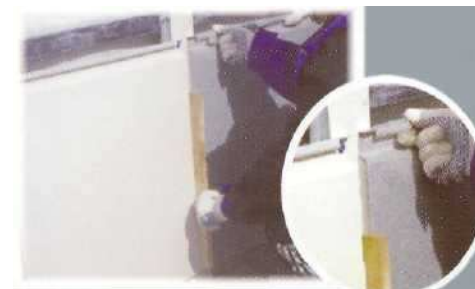
Рис. 3.49. Установка касети зправа
