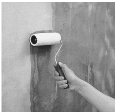
Рис.2.6. Нанесення емульсії ґрунтовки
