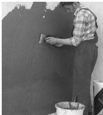
Рис.2.5. . Нанесення другого шару вирівнюючого розчину
