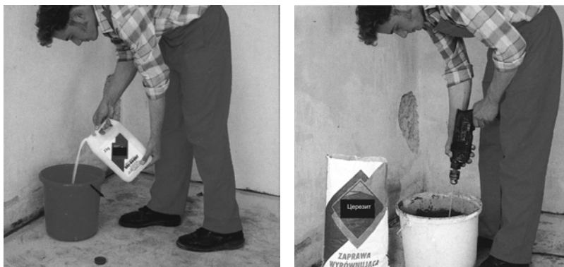
Рис. 2.3. Приготування суміші розчину.
