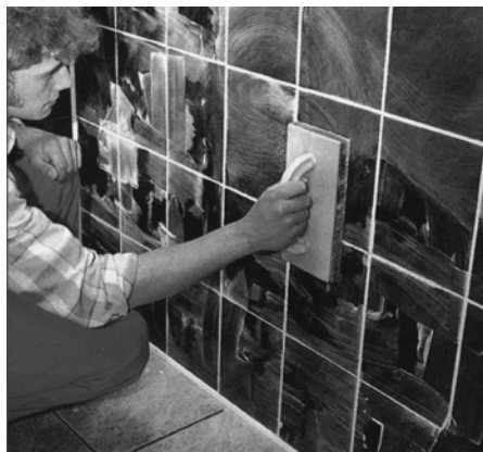
Рис. 2.13. Змивання надлишків клейової суміші
