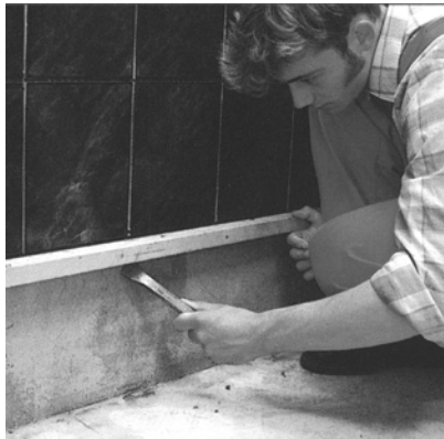
Рис.2.11. Зняття горизонтальної рейки
