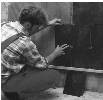
Рис. 2.9. Укладання перших рядів плитки
