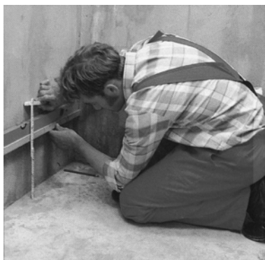
Рис.2.7. Установка горизонтальної рейки
