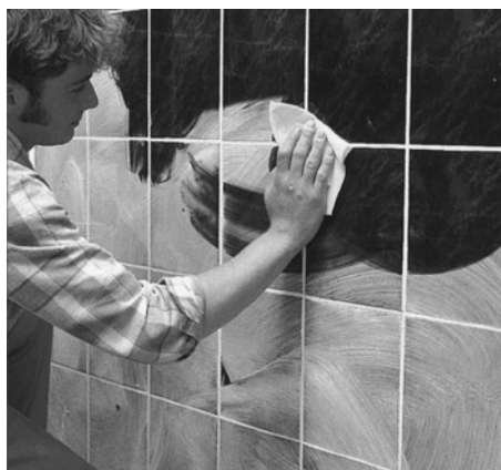
Рис. 2.14. Остаточне очищення плитки водою
