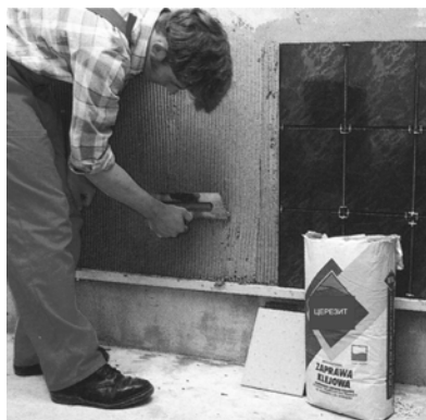
Рис.2.8. Нанесення клейового розчину
