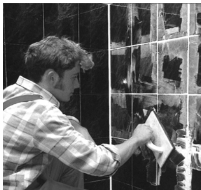
Рис.2.12. Заповнення швів клейовою сумішшю
