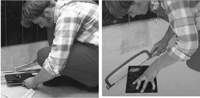
Рис.2.10. Обрізання плитки
