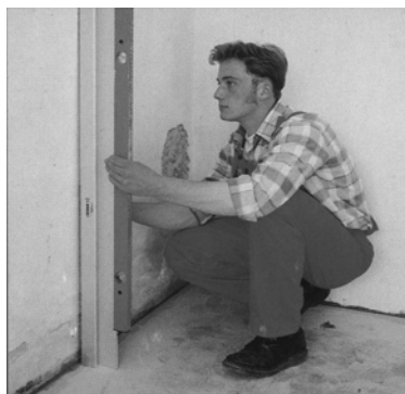
Рис. 2.2. Перевірка відхилень поверхні
