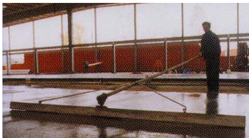
Рис. 1.5. Втирання затверджувача стягуючої рейкою
