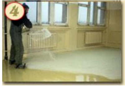
Рис.1.19. Посипання насухо кварцевим піском на підготовлений шар епоксидної маси
