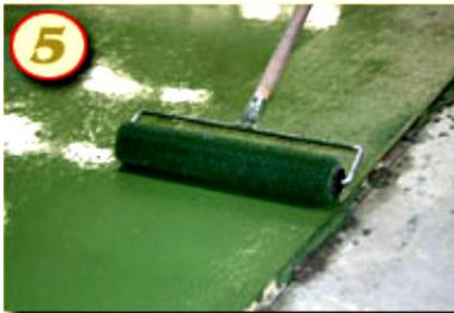
Рис. 1.13. Видалення повітря з шару BAUFLOOR при допомозі валика з голками
