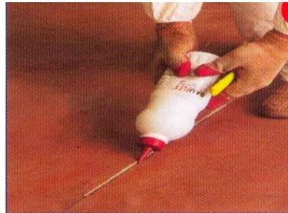
Рис. 1.9. Заповнення швів масою BAUFLEX
