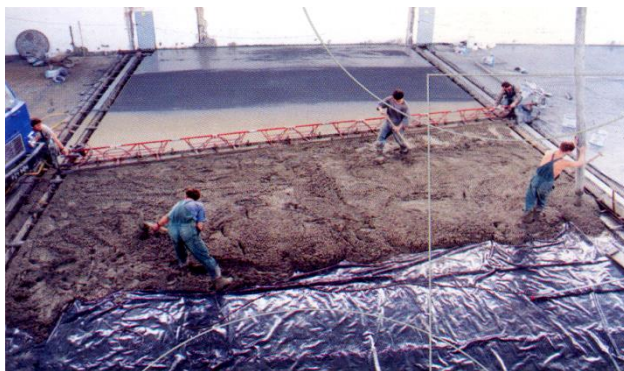
Рис. 1.2. Укладання бетонної суміші
