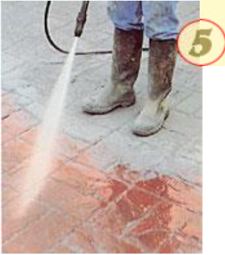
Рис. 1.29. Змивання роздільника струменем води з поверхні застиглому бетону
