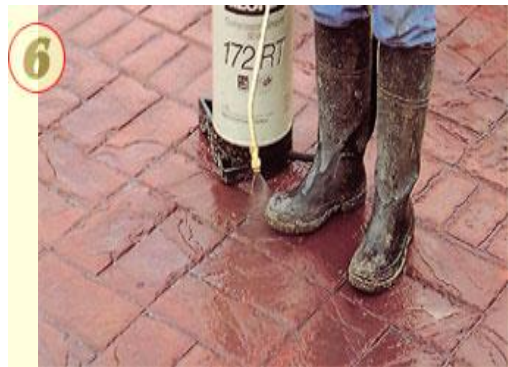
Рис. 1.30. Просочення сухої поверхні акриловим препаратом BAUSEAL додає їй інтенсивний колір і запобігає проникненню води, масел, мастил в тіло бетону.
