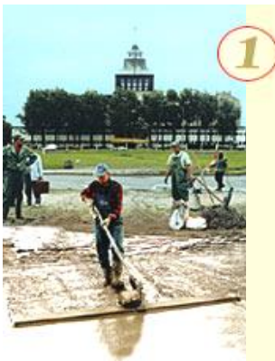
Рис. 1.25. Ущільнення вібраційною рейкою композитного бетону
