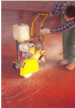
Рис. 1.8. Нарізка усадкових і робочих швів
