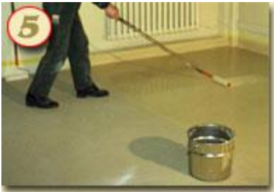
Рис. 1.20. Доопрацювання верхнього шару до насичення
