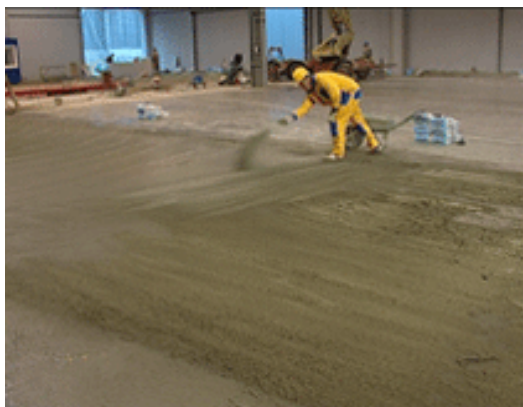
Рис. 1.4. Розсіпка затверджувача
