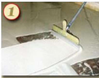
Рис. 1.16. Нанесення і укладання шару вирівнюючої шпаклювальної маси на загрунтовану бетонну основу.
