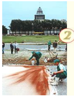
Рис. 1.26. Нанесення кольорового отвердзувача PRESSBETON - MULTITOP на поверхню свіжого бетону
