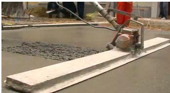
Рис. 1.3. Вирівнювання бетонної суміші
