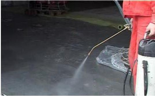
Рис. 1.7. Напилення препарату BAUSEAL
