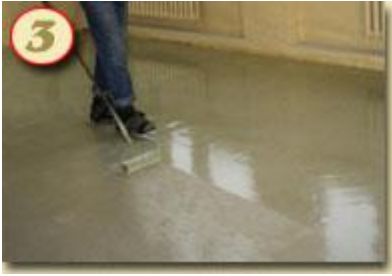
Рис. 1.18. Видалення повітря з поверхні, підготовленої для посипання кварцовим піском
