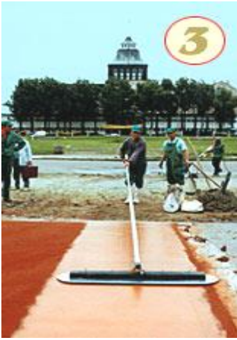
Рис. 1.27. Втирання і розгладження нанесеного отверджувача сталевую теркою
