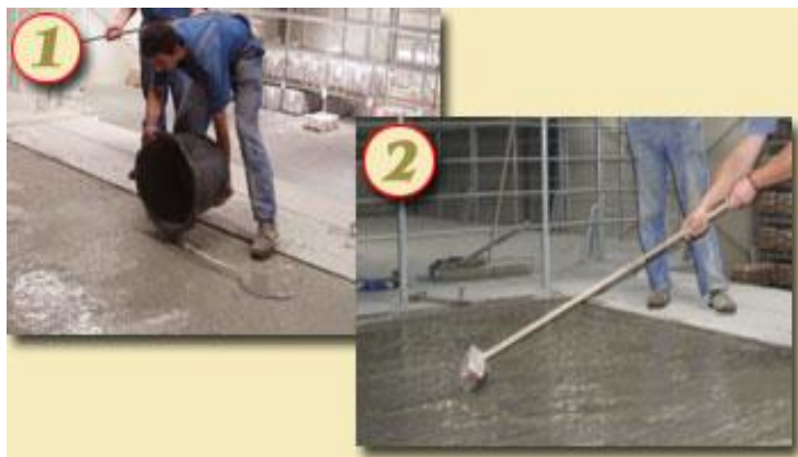
Рис. 1.11. Нанесення препарату BAUBOND.
