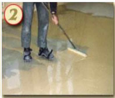
Рис. 1.17. Нанесення і укладання шару епоксидної маси для посипання кварцовим піском
