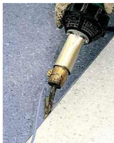
Рис.2.17. Зварювання лінолеуму за допомогою шнура
