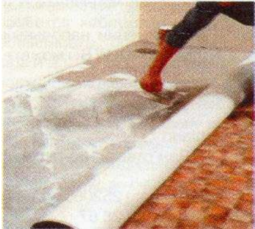
Рис.2.10. Нанесення шару клею
