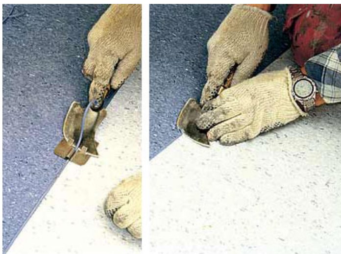
Рис.2.18. Зрізання надлишків шнура і шліфування шва
