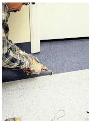
Рис.2.16. Виконання паза між полотнищами лінолеуму
