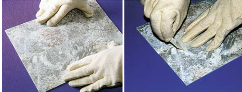
Рис.2.19.Стиковка полотнищ лінолеуму і заклеювання стику скотчем
