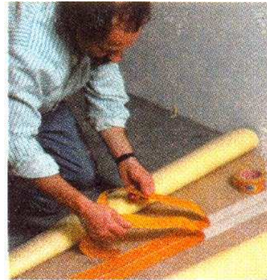
Рис.2.12. Укладання клеючої стрічки
