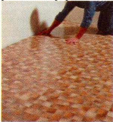
Рис.2.11. Укладання і розгладження лінолеуму
