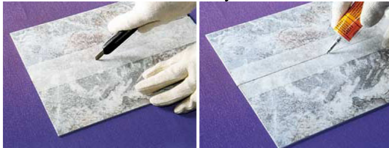
Рис.2.19.Стиковка полотнищ лінолеуму і заклеювання стику скотчем
