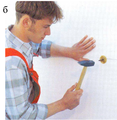
Рис. 2.11 – Закріплення утеплювача дюбелями а – просвердлення отвору; б – забивання дюбелів
