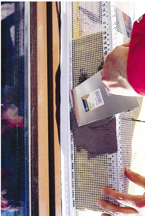
Рис. 2.14 – Підсилення зовнішніх кутів
