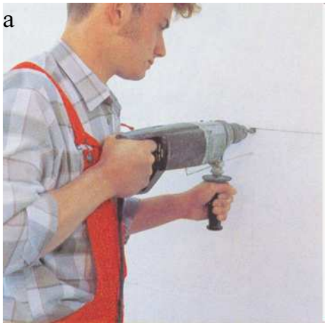
Рис. 2.11 – Закріплення утеплювача дюбелями а – просвердлення отвору; б – забивання дюбелів
