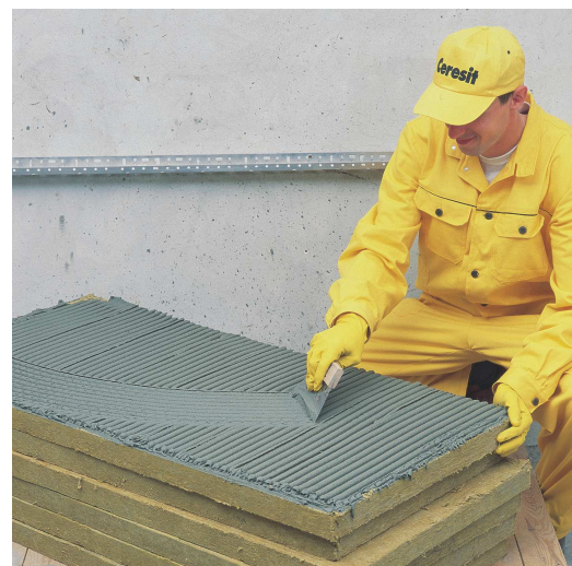
Рис. 2.5 – Нанесення клейового розчину суцільним способом
