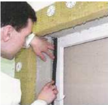
Рис. 2.8. Наклейка стрічки з напуском на коробку
