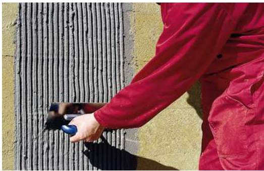
Рис. 2.18. Нанесення клею
