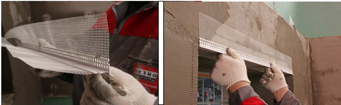
Рис. 2.17 – Армування горизонтальних кутів
