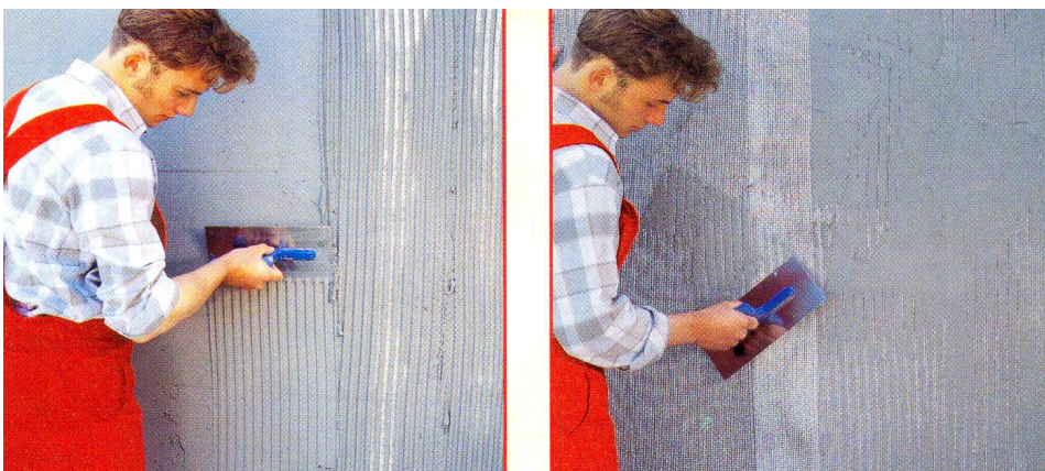
Рис. 2.19 – Укладання та затірка армуючої сітки
