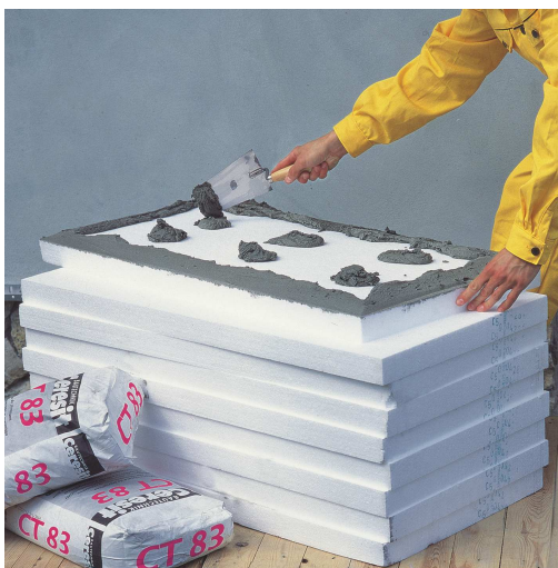
Рис. 2.4 – Нанесення клейового розчину маячковим способом
