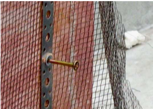
Рис. 3.4 – Кріплення сталеві сітки до плит утеплювача
