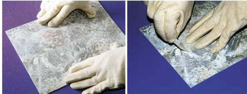
Рис.2.19.Стиковка полотнищ лінолеуму і заклеювання стику скотчем
