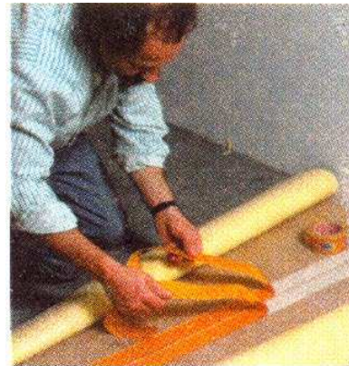
Рис.2.12. Укладання клеючої стрічки
