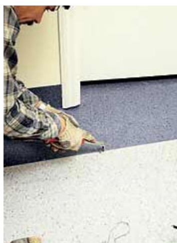
Рис.2.16. Виконання паза між полотнищами лінолеуму
