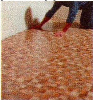
Рис.2.11. Укладання і розгладження лінолеуму
