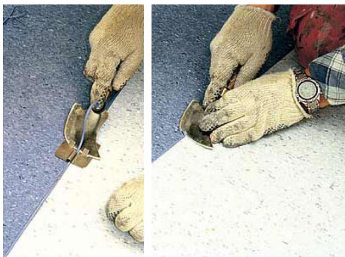
Рис.2.18. Зрізання надлишків шнура і шліфування шва
