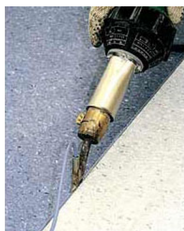
Рис.2.17. Зварювання лінолеуму за допомогою шнура
