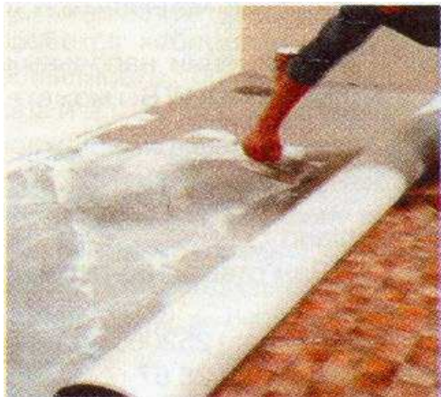
Рис.2.10. Нанесення шару клею
