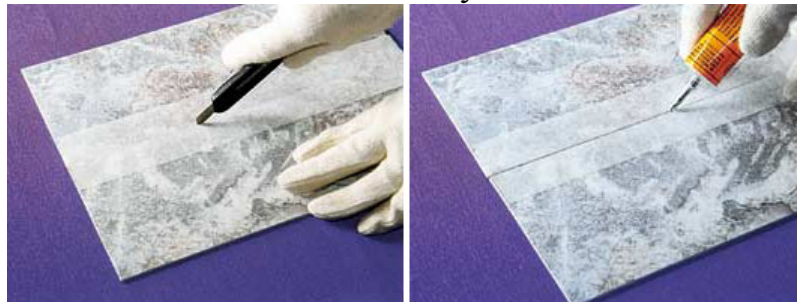
Рис.2.19.Стиковка полотнищ лінолеуму і заклеювання стику скотчем
